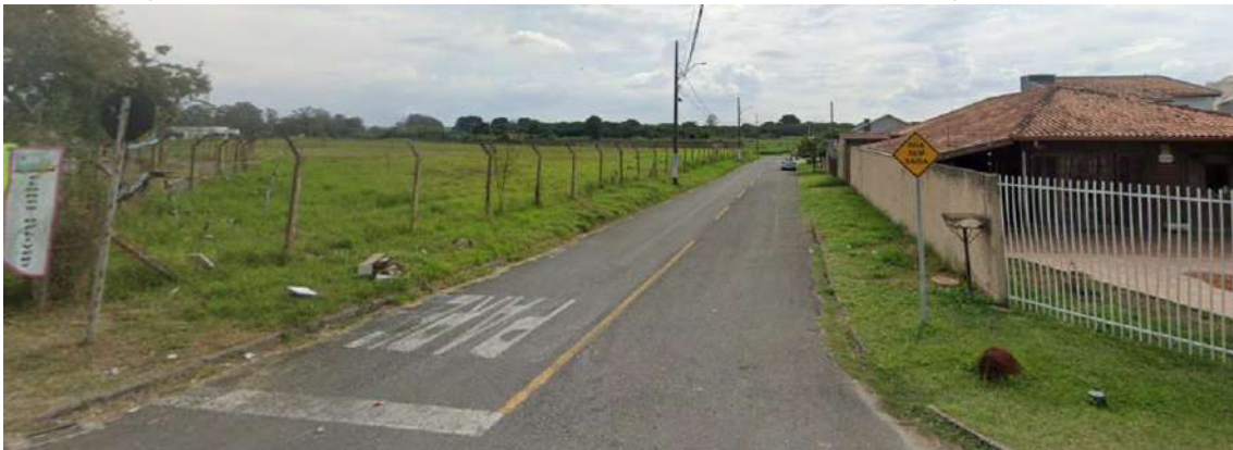
Figura 18. R. Jalton Laffite Cordeiro, em trecho defronte ao lote do empreendimento
