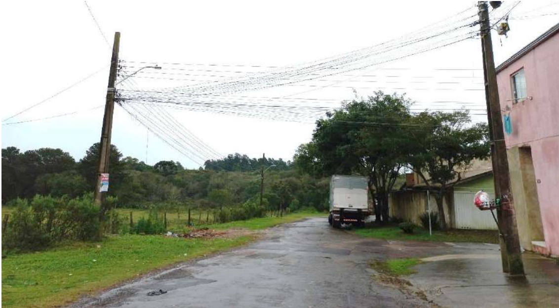
Figura 22. Rua Casimiro Poli, em trecho defronte ao lote do empreendimento
