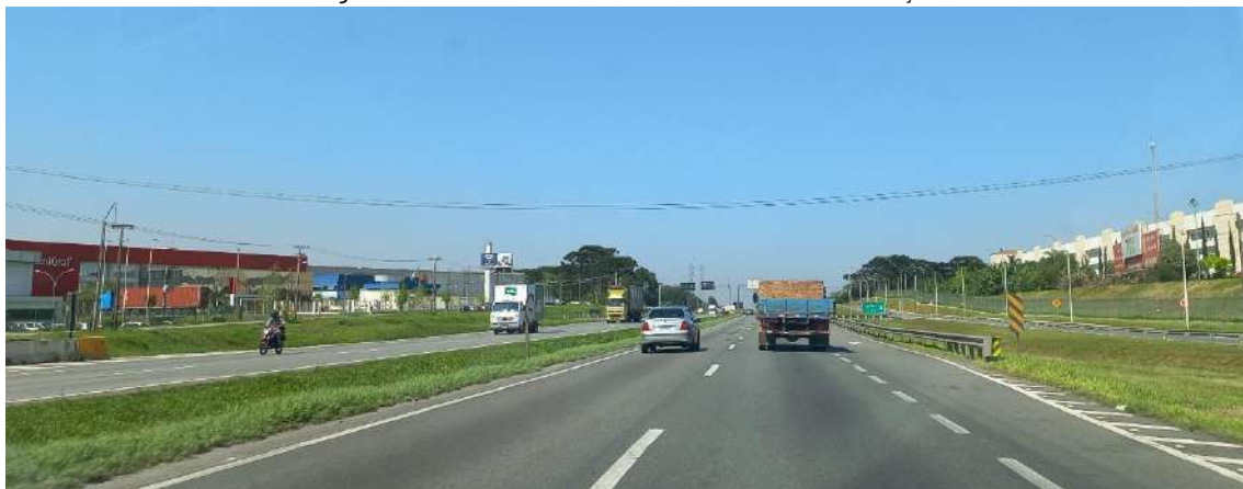
Figura 26. Rodovia Federal BR-116, via de distribuição
