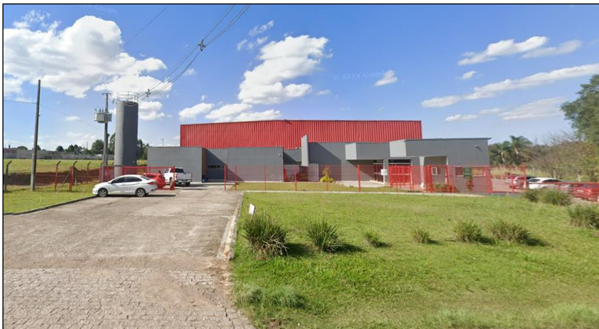
Imagem 21: Também na Rua Pedro Valaski está situada a Empresa Poliumetka Indústria de Telhas e Lajes EPS, ainda dentro da área de interferência Direta a 480,00m do Empreendimento.
