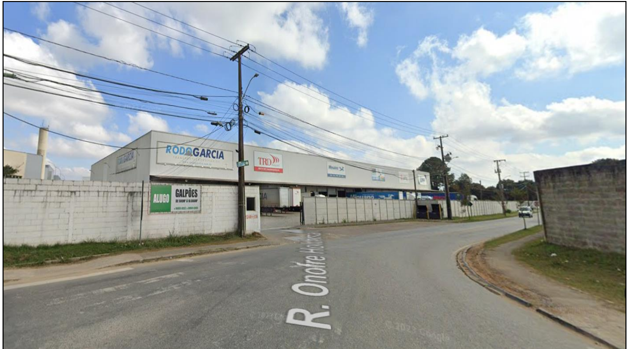
Imagem 27: Na Rua Onofre Holthman encontra-se a Empresa Rodogarcia Transportes Rodoviários, distante 835,00m do Empreendimento em estudo.e dentro da Área de Influência Indireta.
