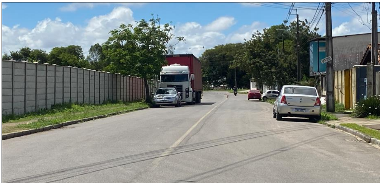
Imagem 30: Vista da Rua Constante Moro Sobrinho em frente ao muro do Empreendimento.
