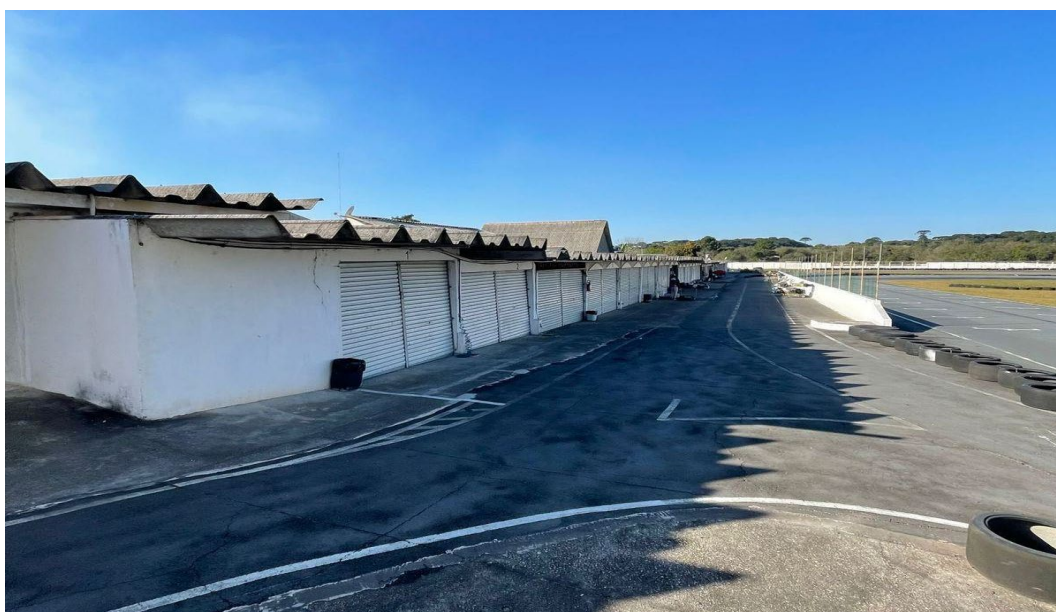
Figura 32 - Vista Geral dos Boxes 03 (Fonte: Os Autores, 2023)
