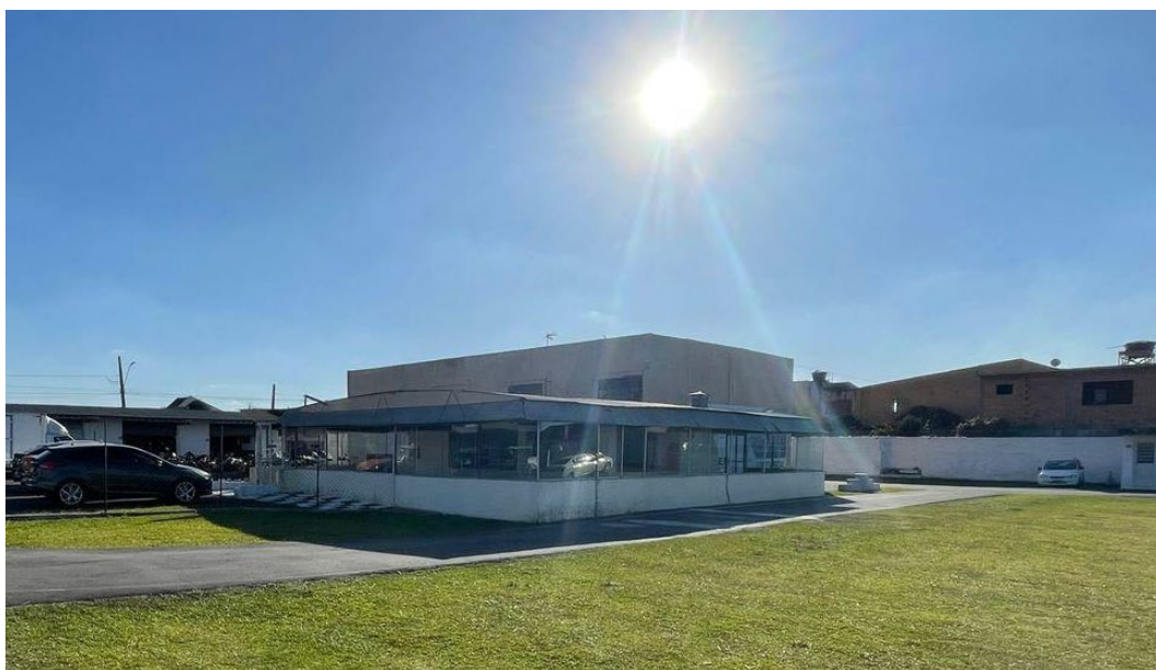
Figura 33 - Vista Geral da Lanchonete (Fonte: Os Autores, 2023)
