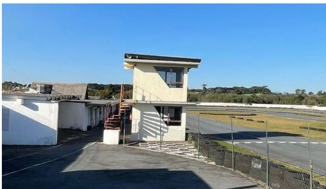
Figura 34 - Torre de Observação (Fonte: os autores, 2023)
