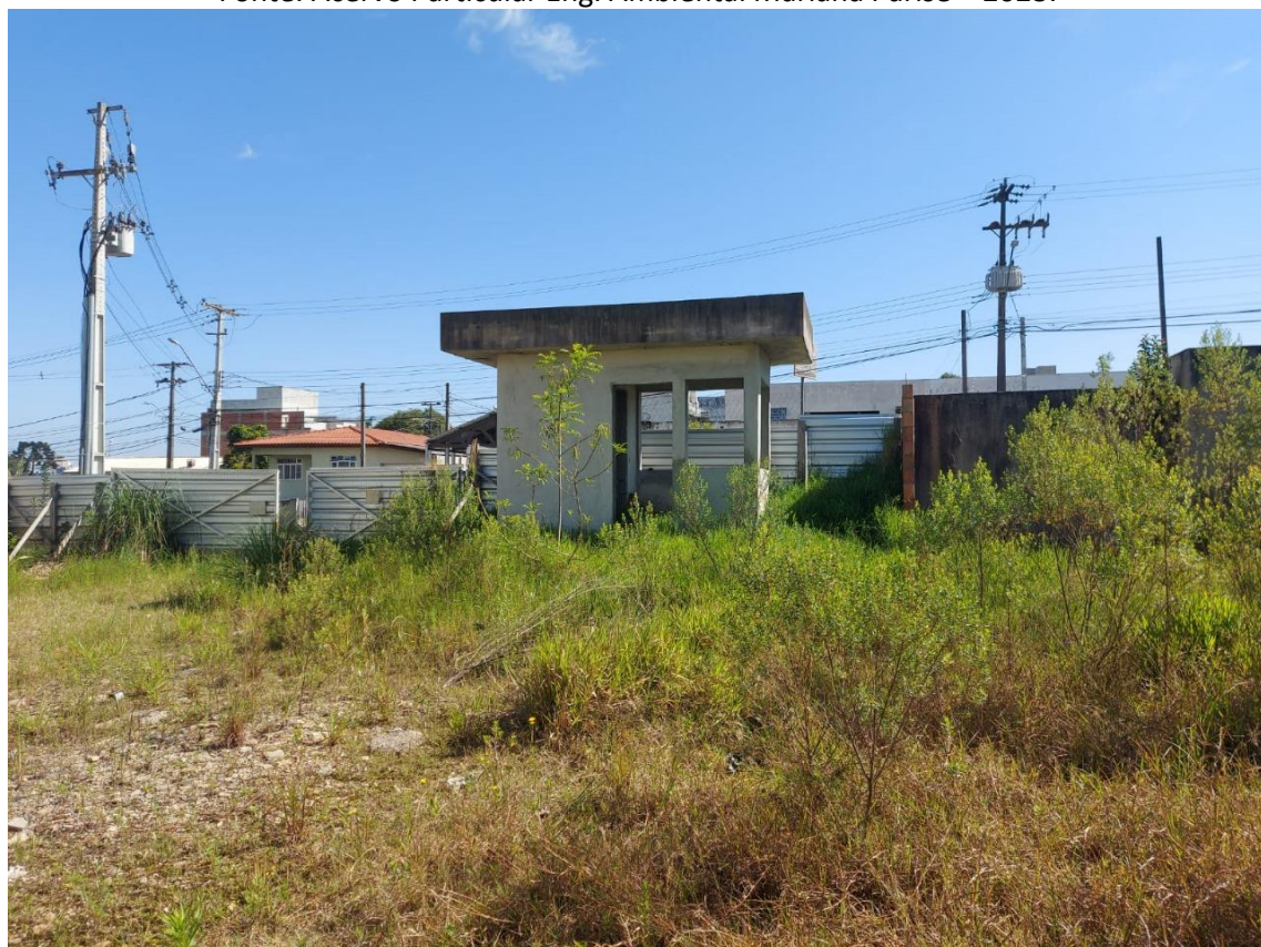
Figura 13: Área Construída Existente do Lote F869.
