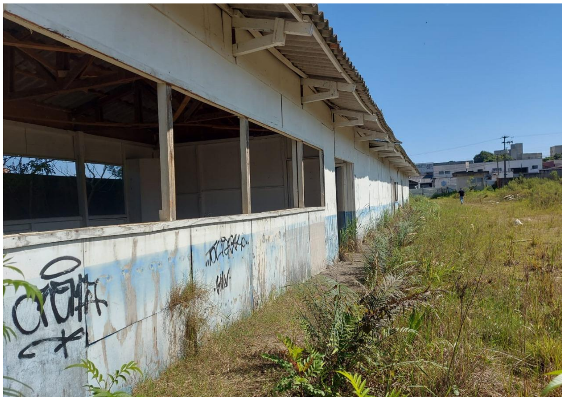
Figura 12: Área Construída Existente do Lote F869.
