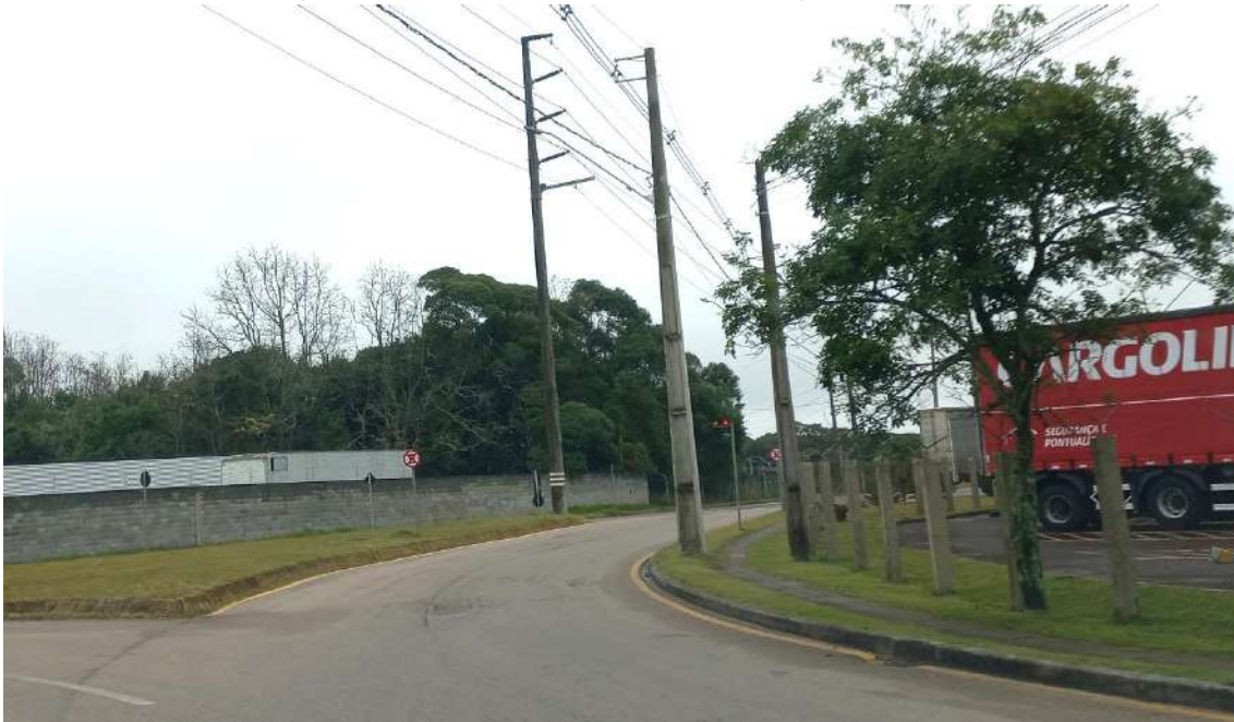
Figura 19. Av. Industrial, via de acesso ao empreendimento
