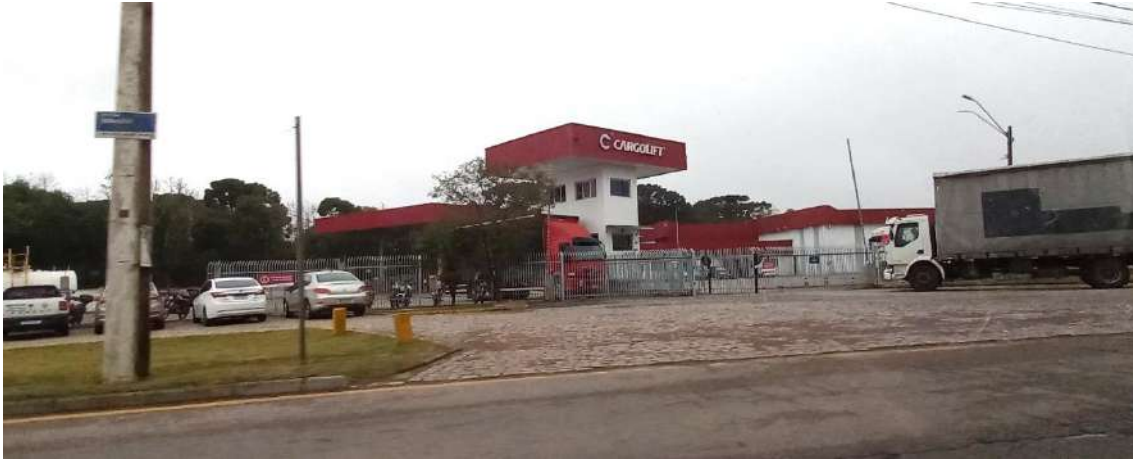
Figura 10. Acesso atual ao empreendimento, com frente p/ a Av. Industrial
