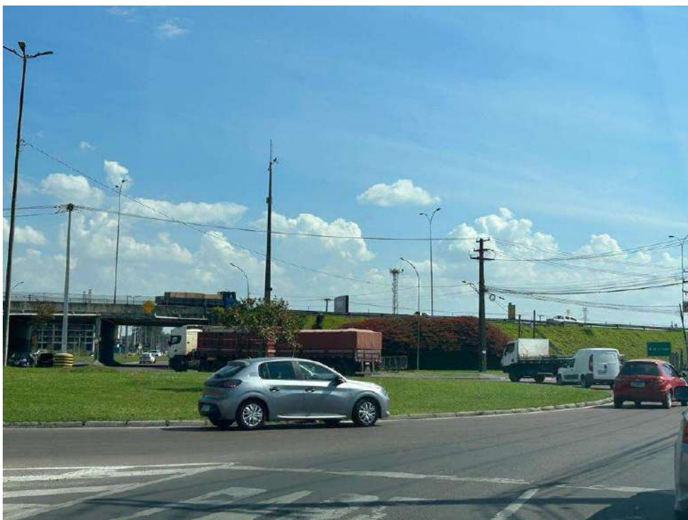
Figura 28 – AV. Rui Barbosa, cruzamento trincheira com BR277.
