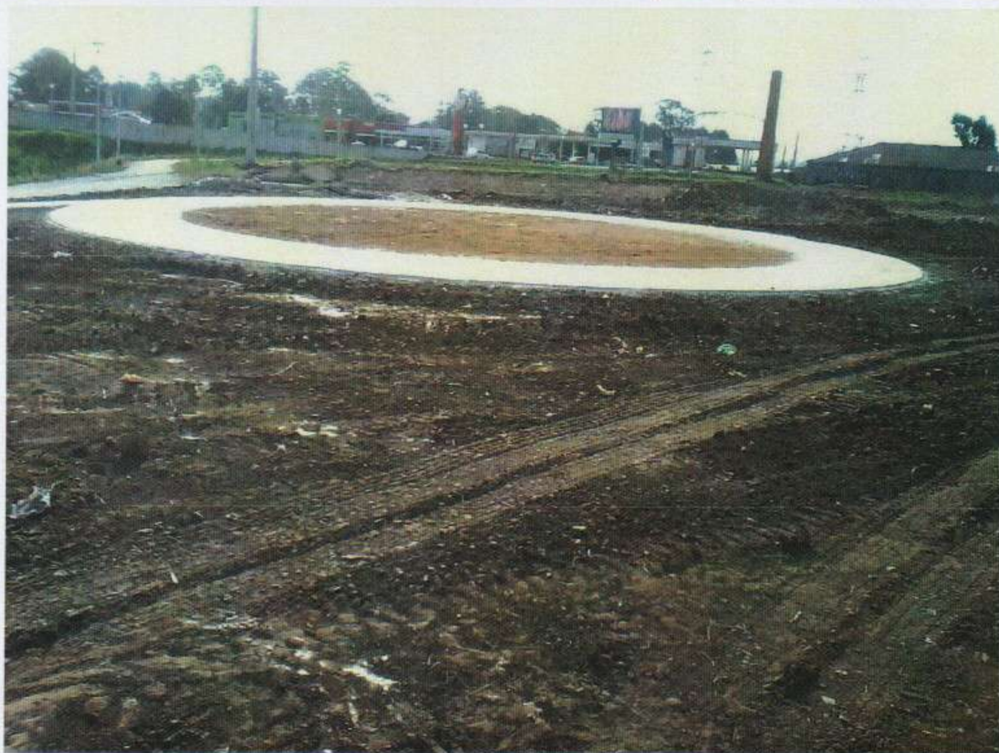
Foto 2. Construção de academia ao ar livre e preparação do terreno para o plantio da grama – 05/04/16
