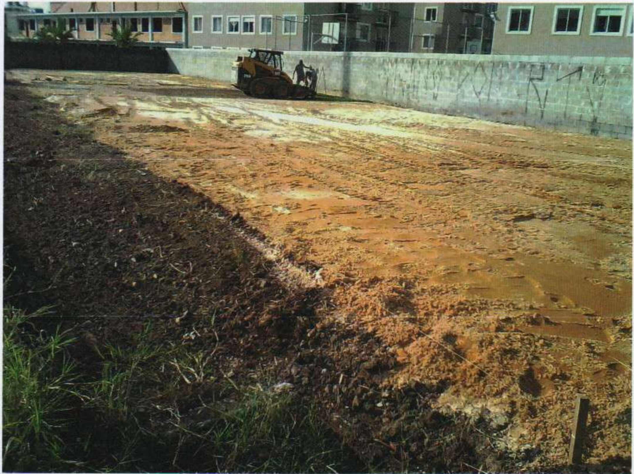
Foto 1. Construção de canchas de futebol – 05/04/16
