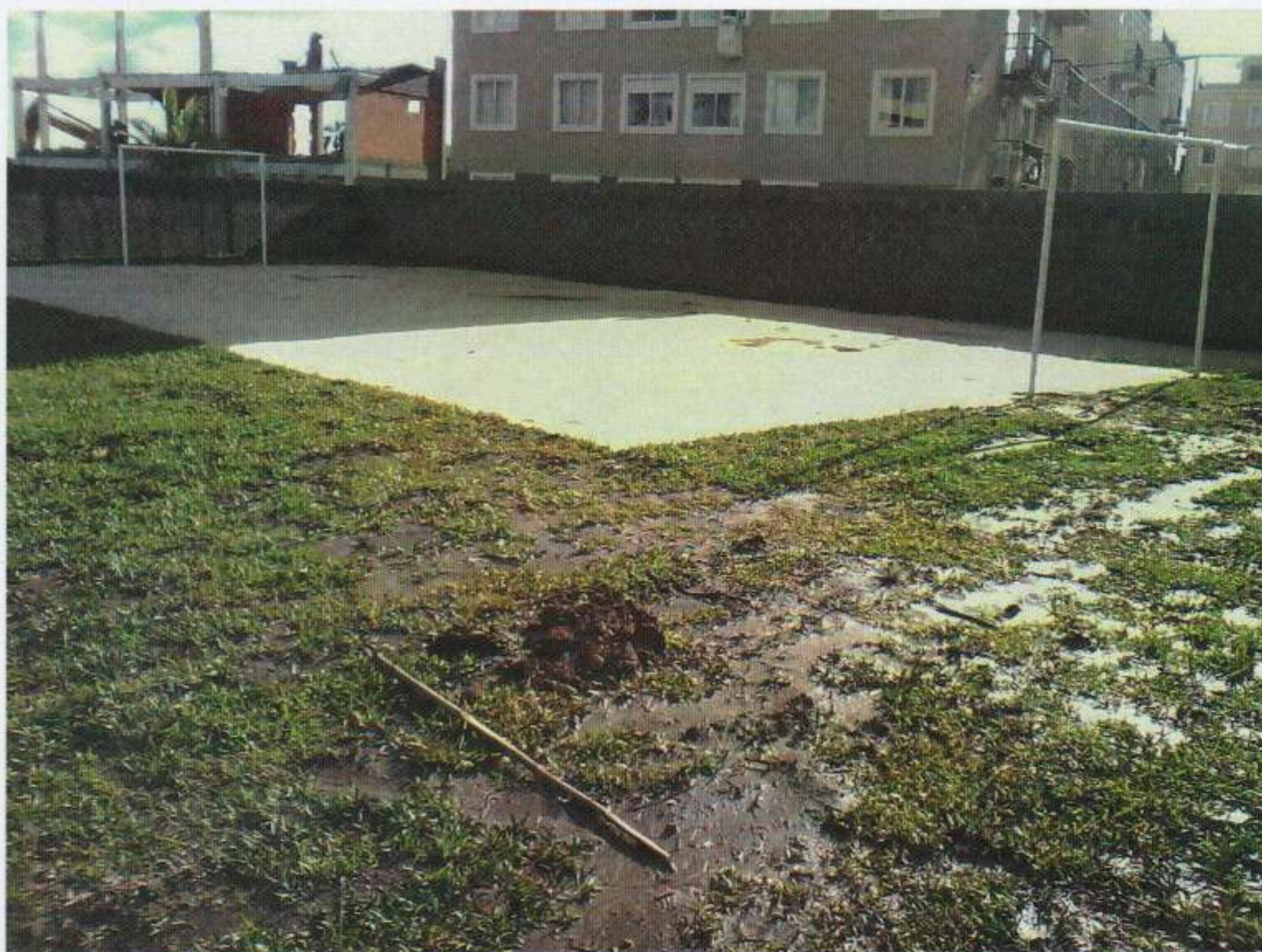
Foto 7. Plantio de grama e instalação de traves – 20/05/16
