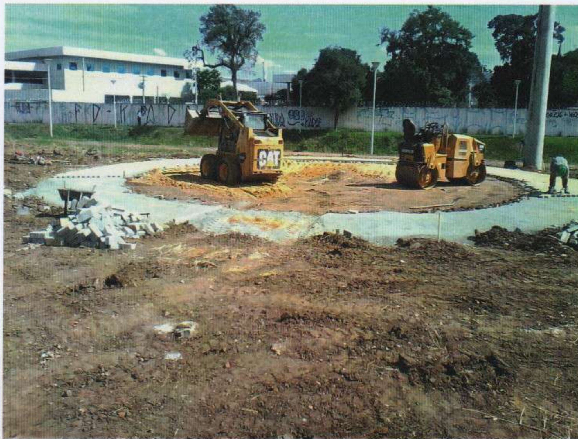
Foto 1. Construção de academia ao ar livre – 29/03/16
