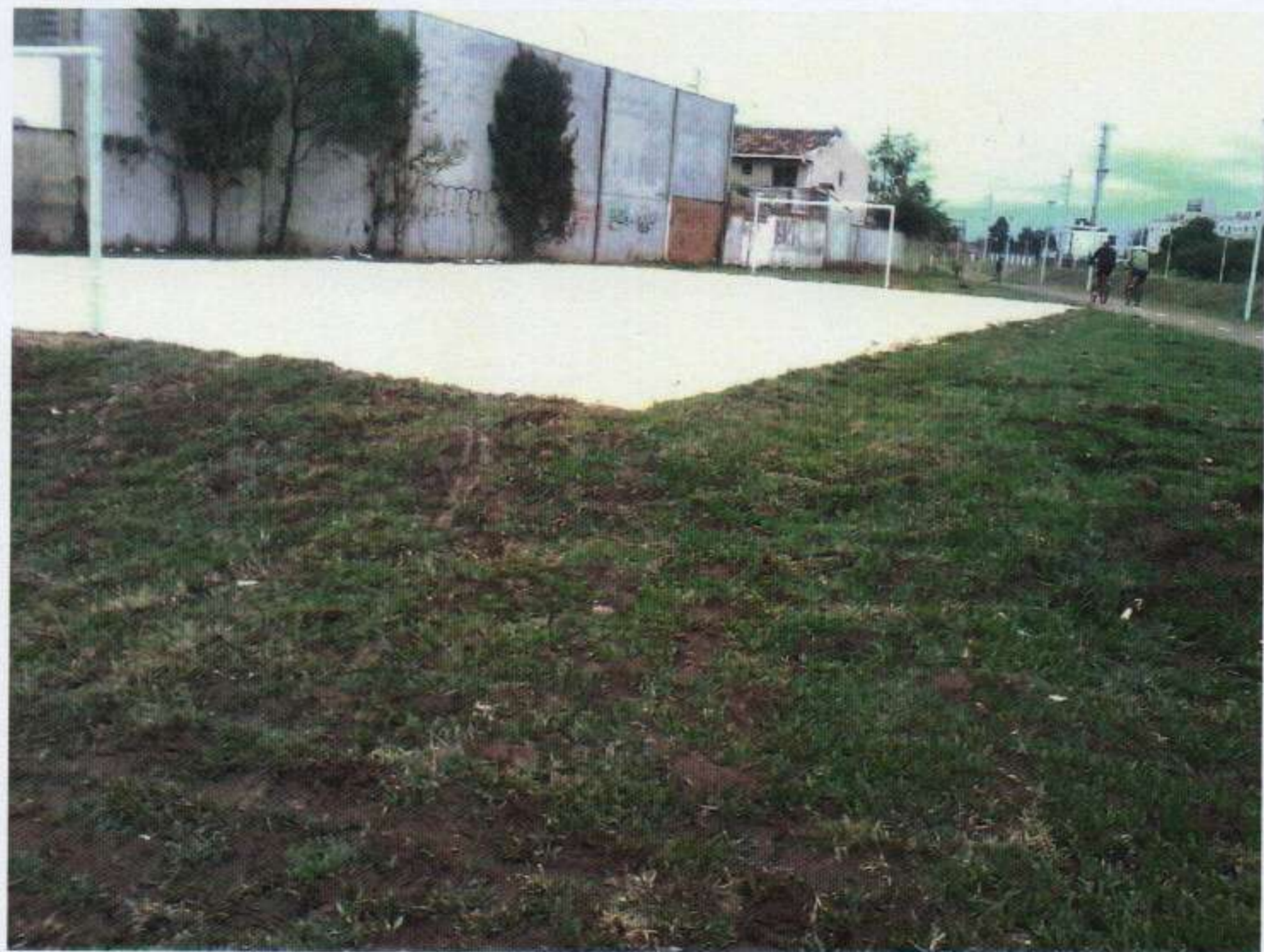
Foto 6. Plantio de grama e instalação de traves – 20/05/16
