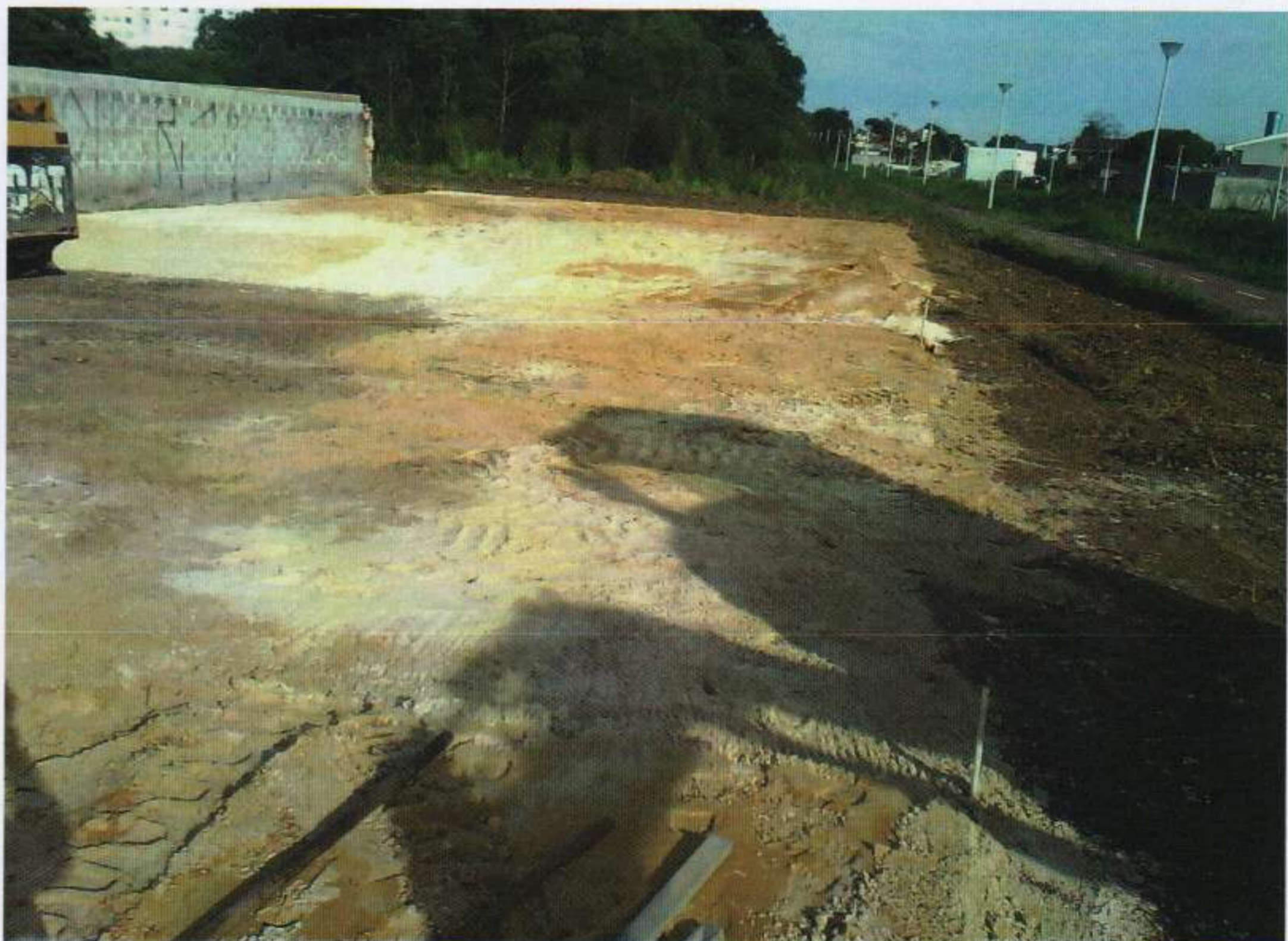
Foto 2. Construção de canchas de futebol – 05/04/16
