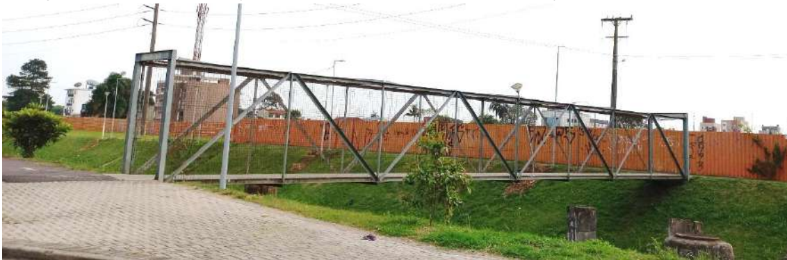
Figura 13. Ponte metálica de pedestres executada sobre o Rio Ressaca, próximo à R. Pérola do Oeste
