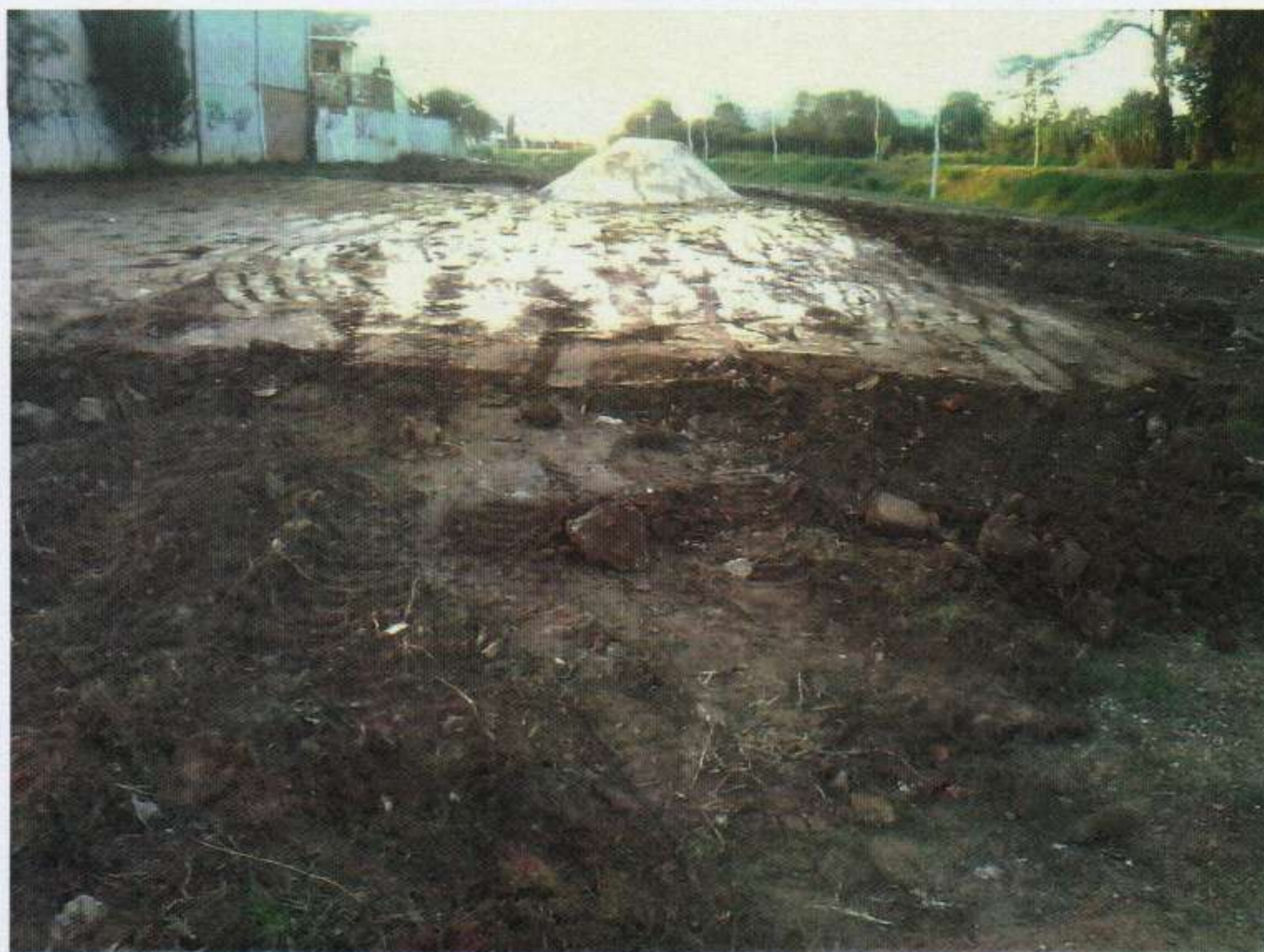
Foto 3. Construção de academia ao ar livre e preparação do terreno para o plantio da grama – 18/04/16
