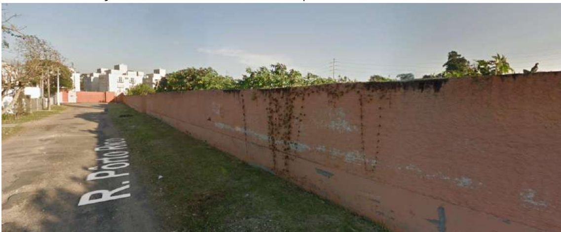
Figura 8. Testada do terreno com frente para a R. Porto Rico, ano de 2018
