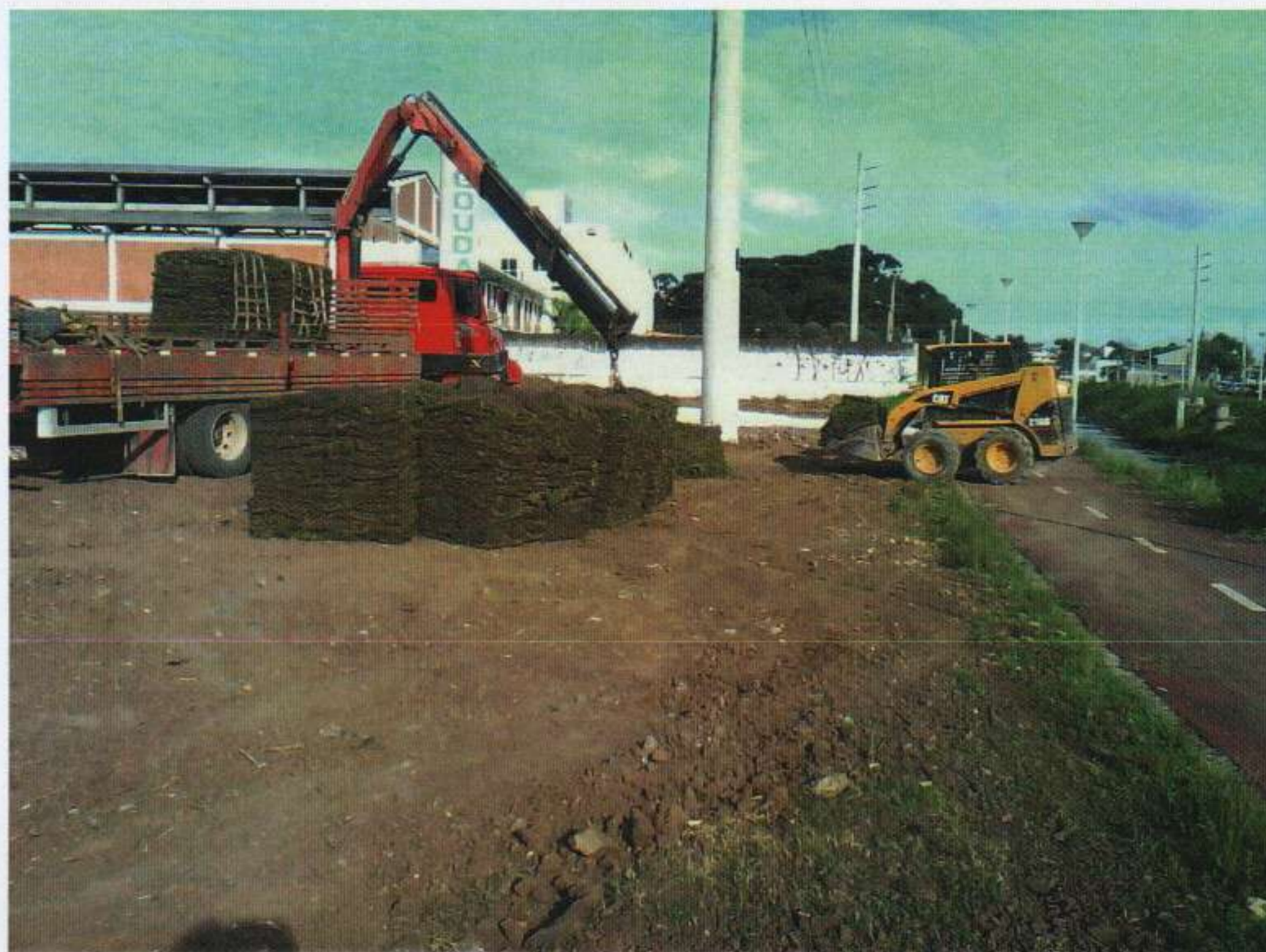
Foto 3. Construção de academia ao ar livre e preparação do terreno para o plantio da grama – 05/04/16
