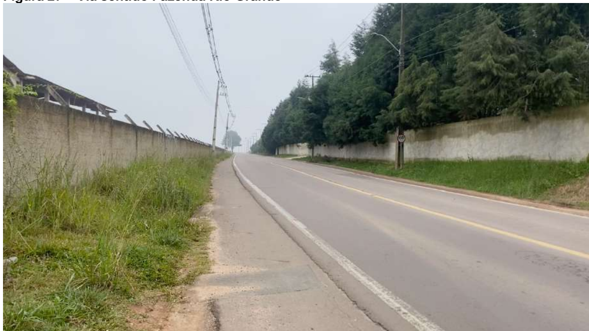
Figura 27 – Via sentido Fazenda Rio Grande
