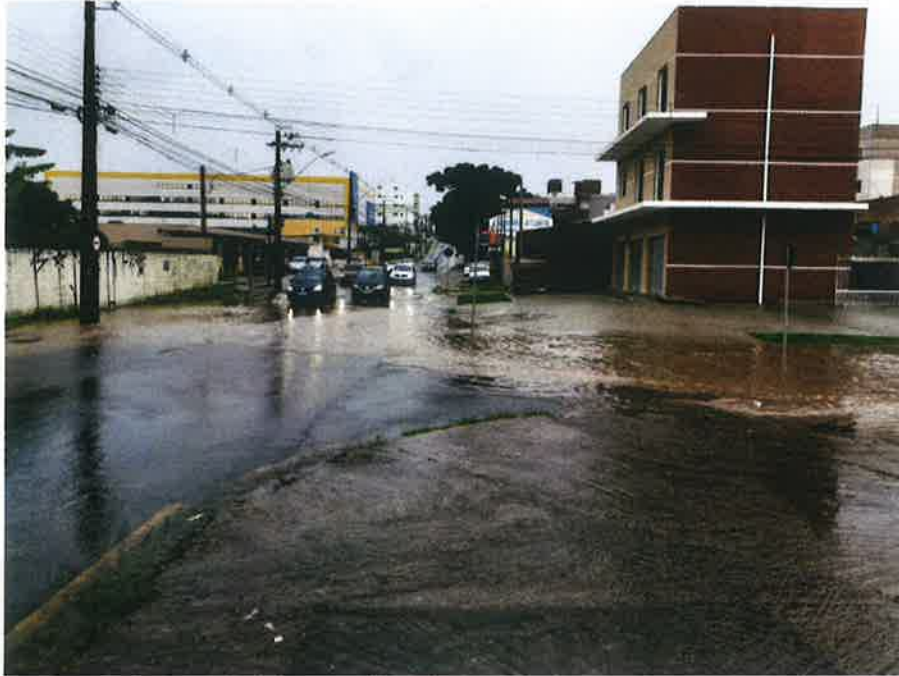
Rua Almirante Alexandrino esquina com a Rua José Sczepanski. Neste caso a origem das águas é a faixa de aproximação do Aeroporto.
