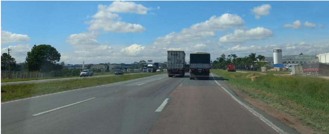
Figura 23. Rodovia Federal BR-116, via de distribuição
