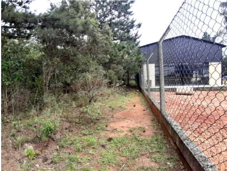
Edificação em fase de regularização (refeitório).
