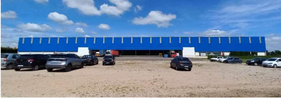
Figura 12. Construção existente no terreno
