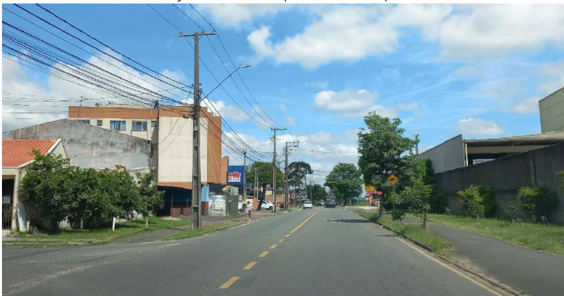
Figura 24. Alameda Arpo, via de distribuição
