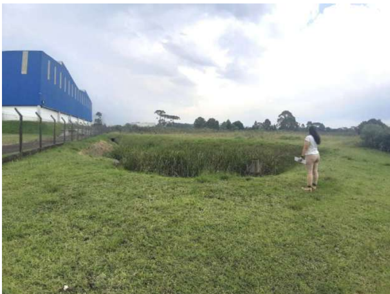
Registro de caixa de contenção de cheias.
