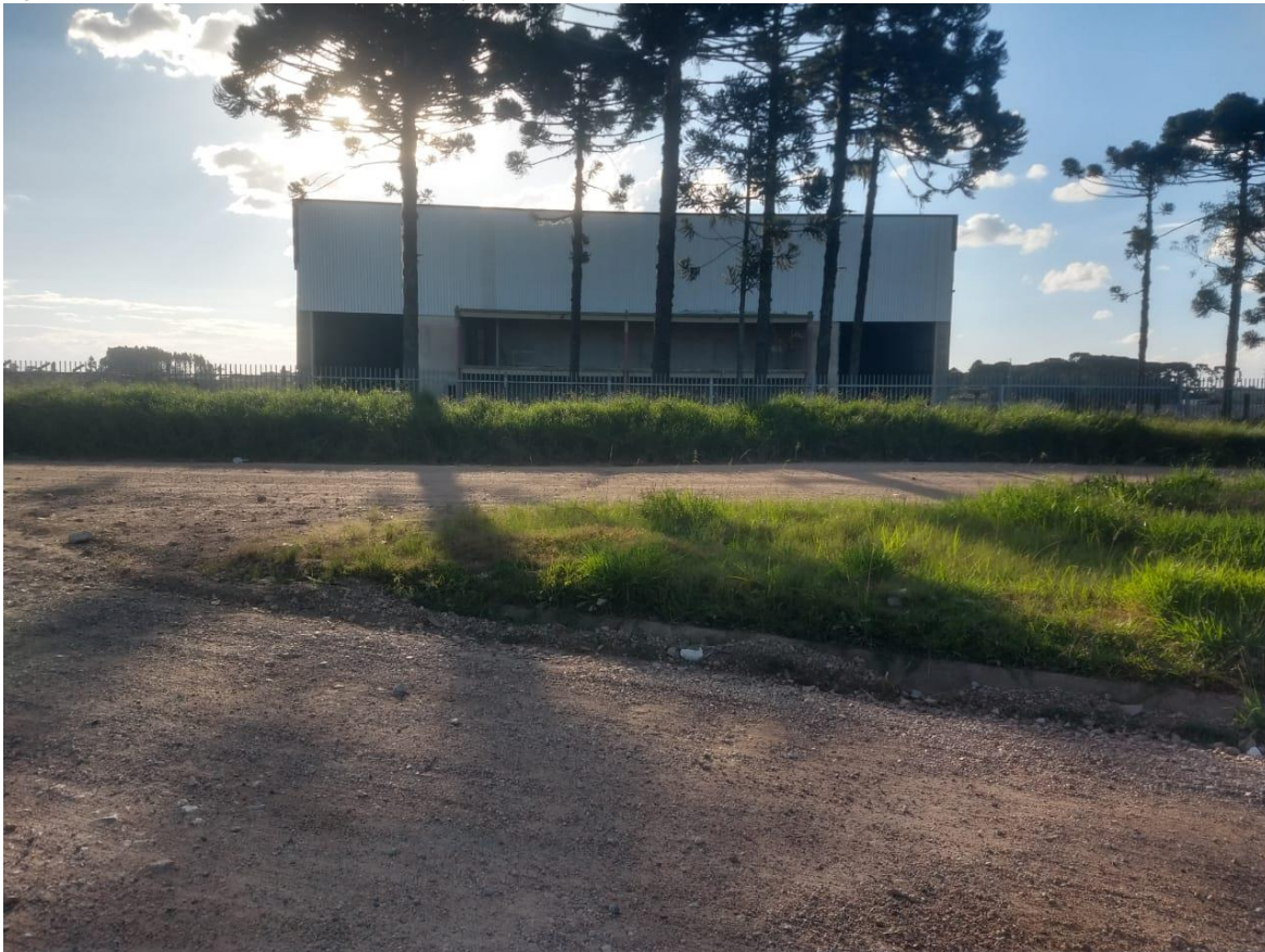
Figura 11: Foto de vias aos arredores do empreendimento.
