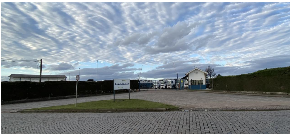
Imagem 35: Vista do acesso ao pátio da Transauto Transportes Especiais de Automóveis, localizada na Rua Dr. Murici.
