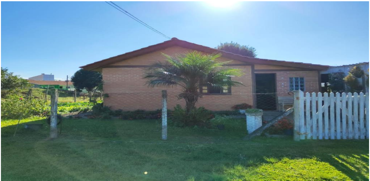
Figura 22: Fachada da Casa do Caseiro situada próximo ao Salão de Festas.
