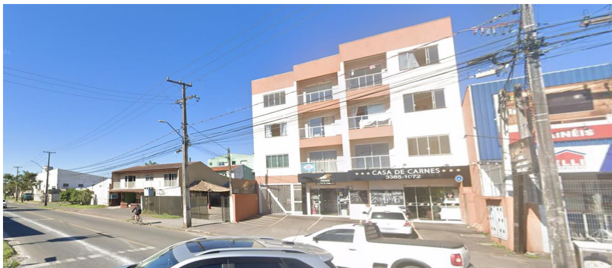
Figura 27: Vista das unidades residenciais e comerciais existentes na Alameda Arpo, próximos ao Empreendimento.
