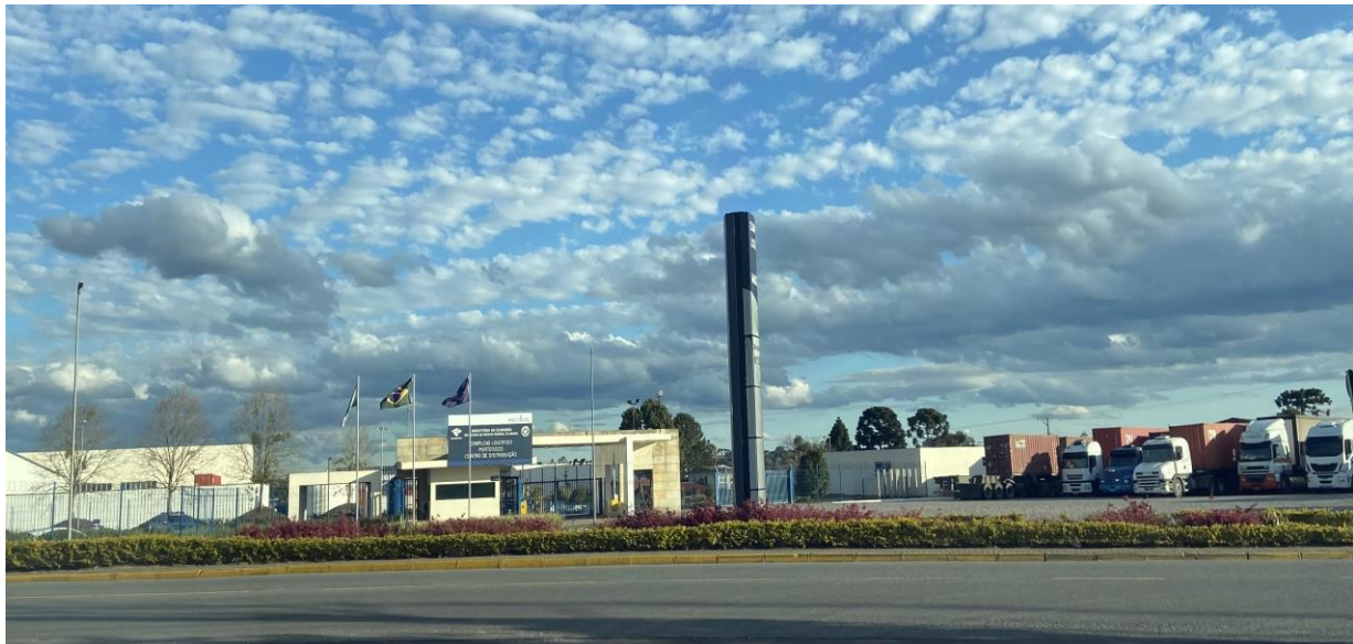
Imagem 37: Fachada da Multilog Porto Seco SJP, situada na Rua João Zarpelon.
