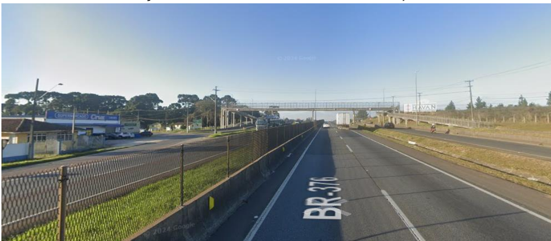
Figura 27. Rodovia Federal BR-376, via de distribuição
