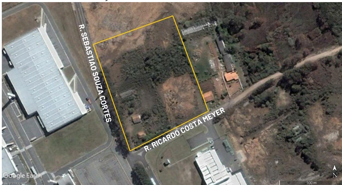
Figura 1. Foto aérea do imóvel no ano de 2004
