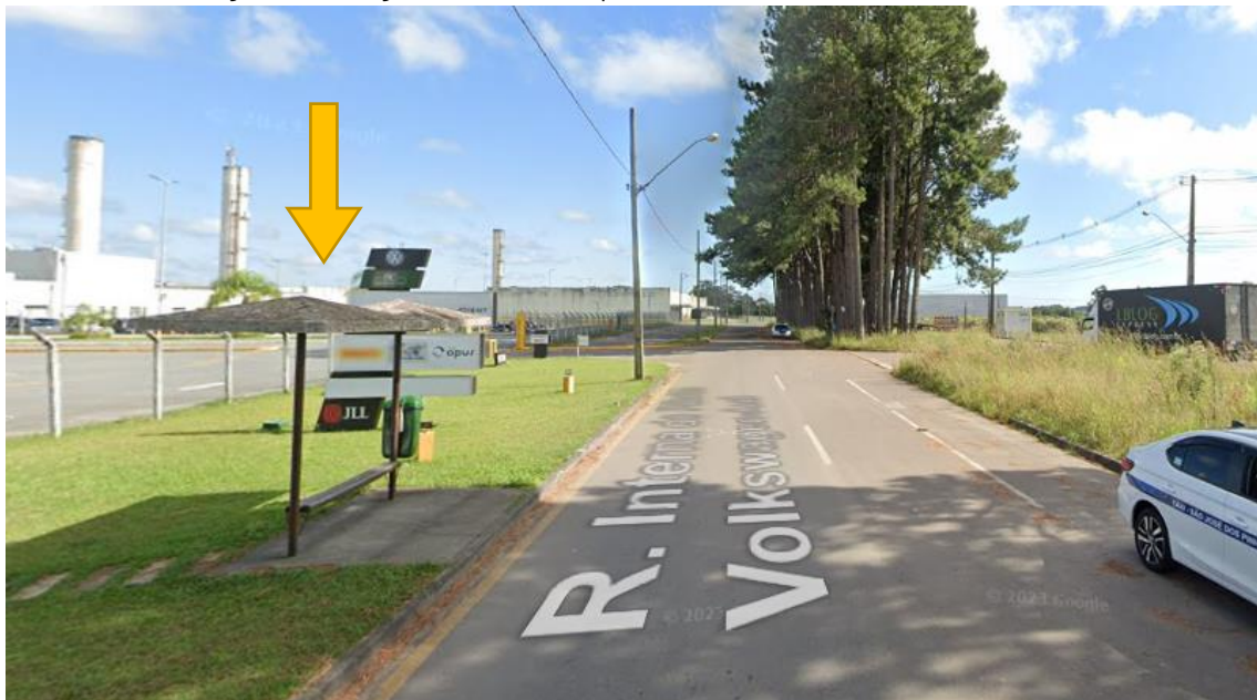
Figura 28. Abrigo de ônibus mais próximo, na R. Sebastião Souza Côrtes
