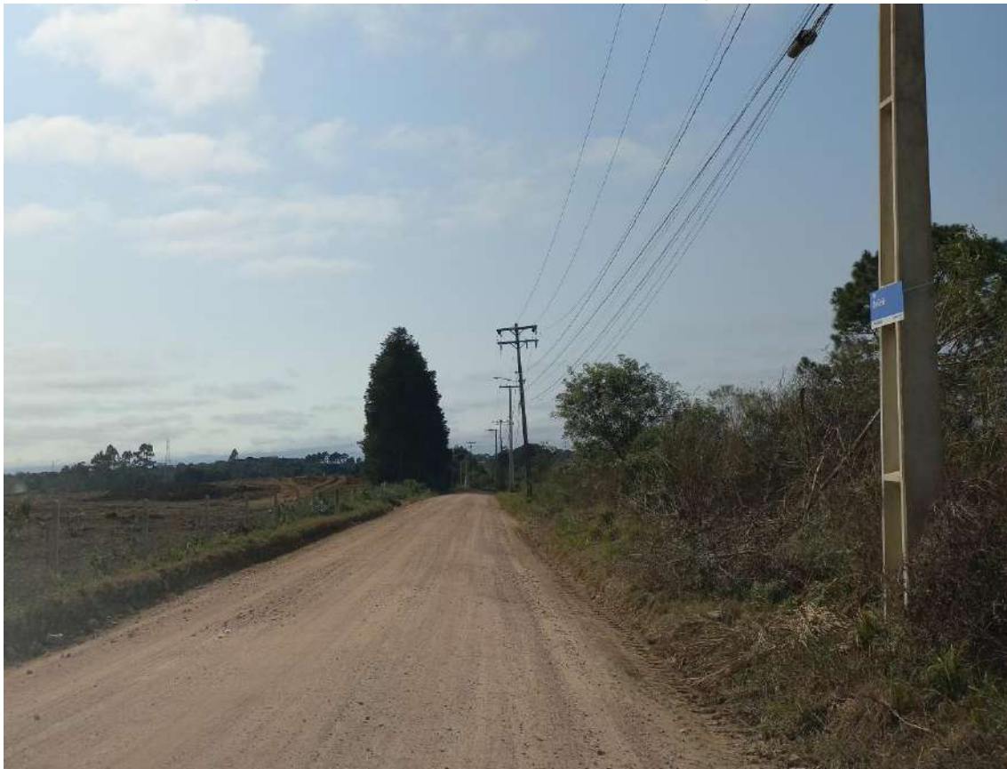
Figura 18. R. do Gerê, em trecho defronte ao lote do empreendimento
