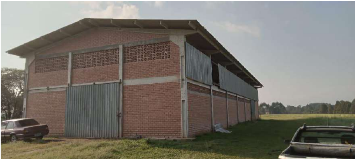
Figura 12. Barracão originalmente existente, atualmente em processo de demolição
