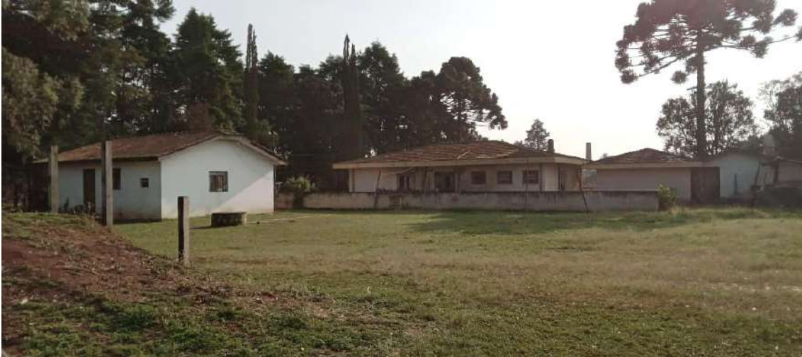
Figura 11. Construções residenciais originalmente existentes, atualmente em processo de demolição
