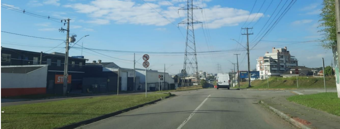
Figura 25. Avenida das Torres - via de distribuição
