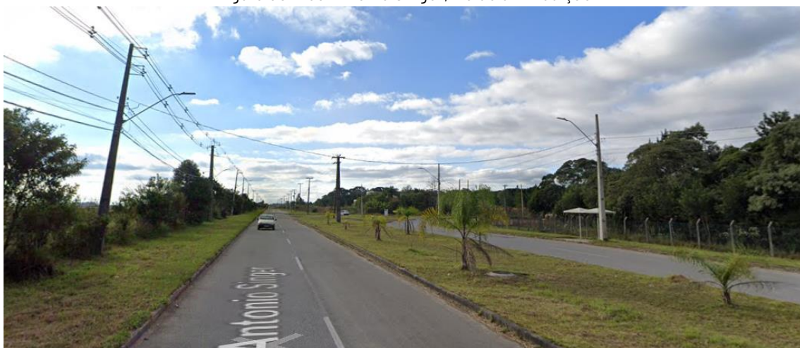
Figura 30. Rua Antônio Singer, via de distribuição
