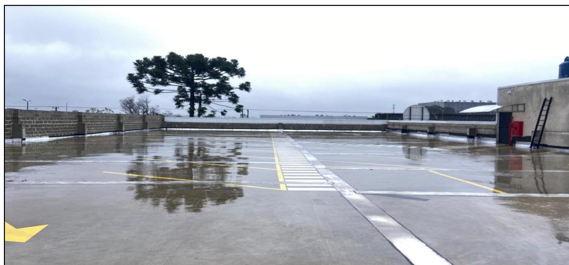
Imagem 22: Área de estacionamento descoberto no 3º pavimento (terraço) do Centro Comercial.
