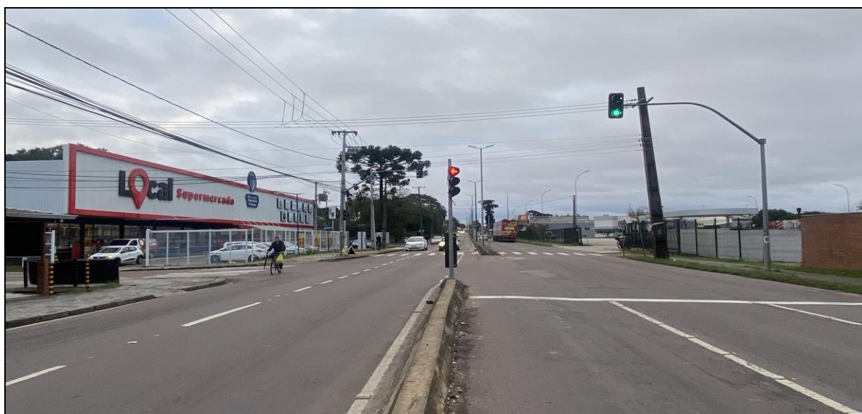
Imagem 12: Vista da Avenida Rui Barbosa (ECS2) em frente ao Empreendimento, após a revitalização desta via.
