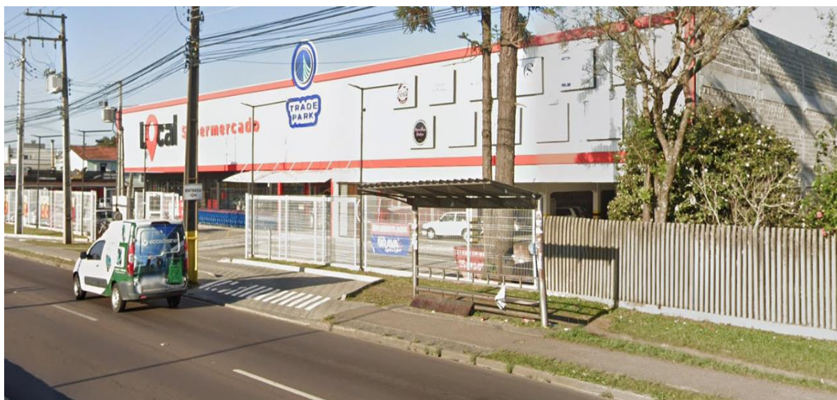
Imagem 35: Ponto de ônibus existente junto ao acesso do Centro Comercial na Avenida Rui Barbosa (sentido bairros).
