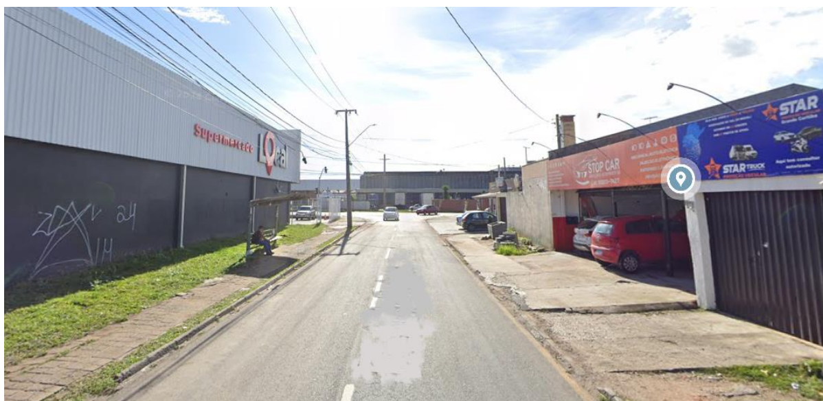
Imagem 34: Vista da Rua Adir Pedroso com passeios inadequados para pedestres.
