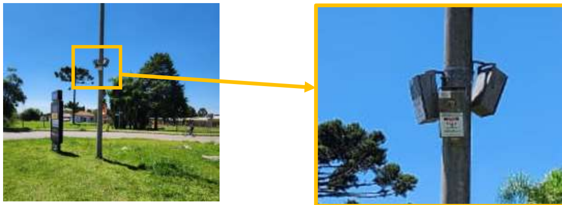
Figura 3-1. Equipamento instalado no cruzamento das Ruas Dr. Murici e João Zarpelon.
