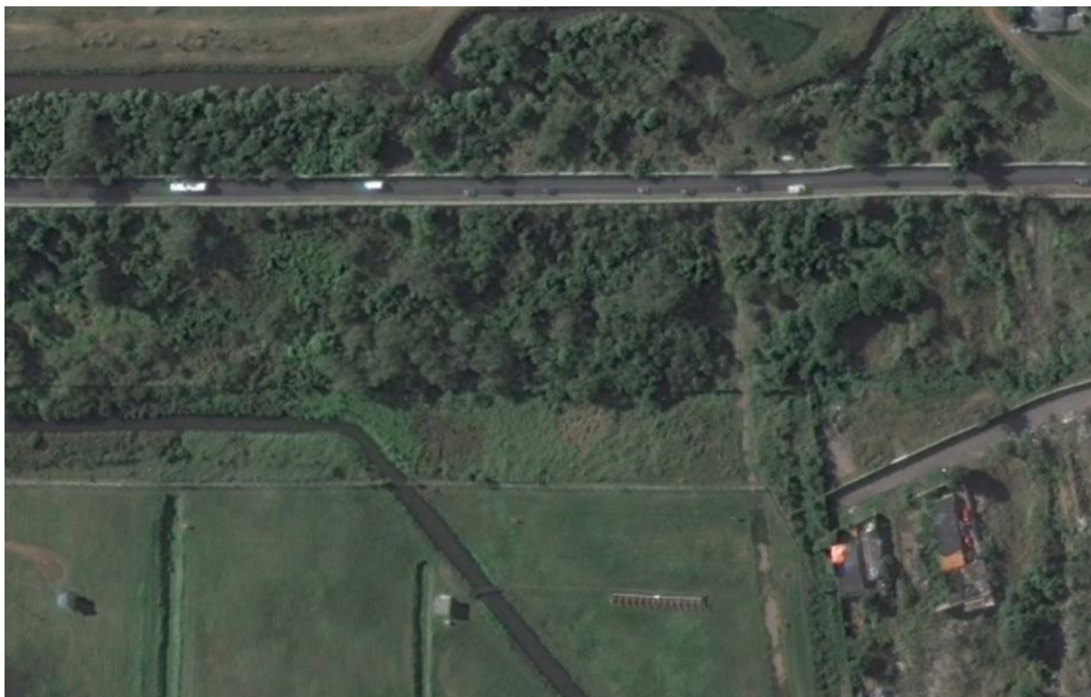
Figura 3-7: Vista aérea do trecho da Avenida Dique que foi desativado.
