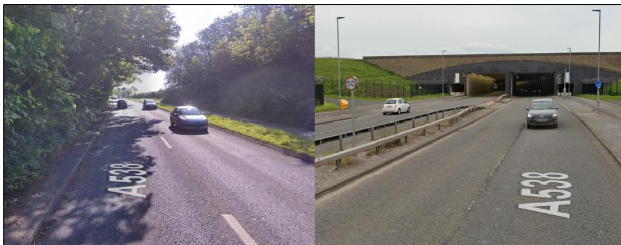
Figura 3-2: Autoestrada A538, trecho aberto e trecho em túnel
