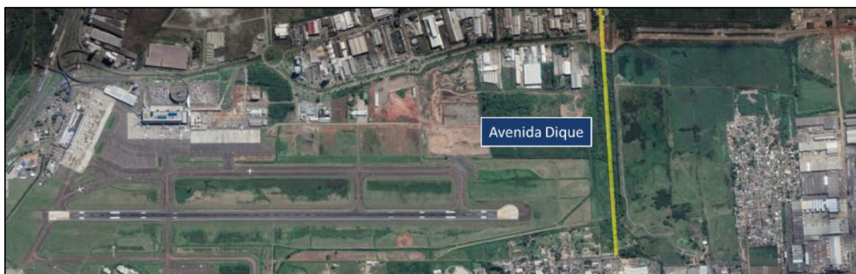
Figura 3-6: Aeroporto Internacional de Porto Alegre e Avenida Dique, 07/2018
