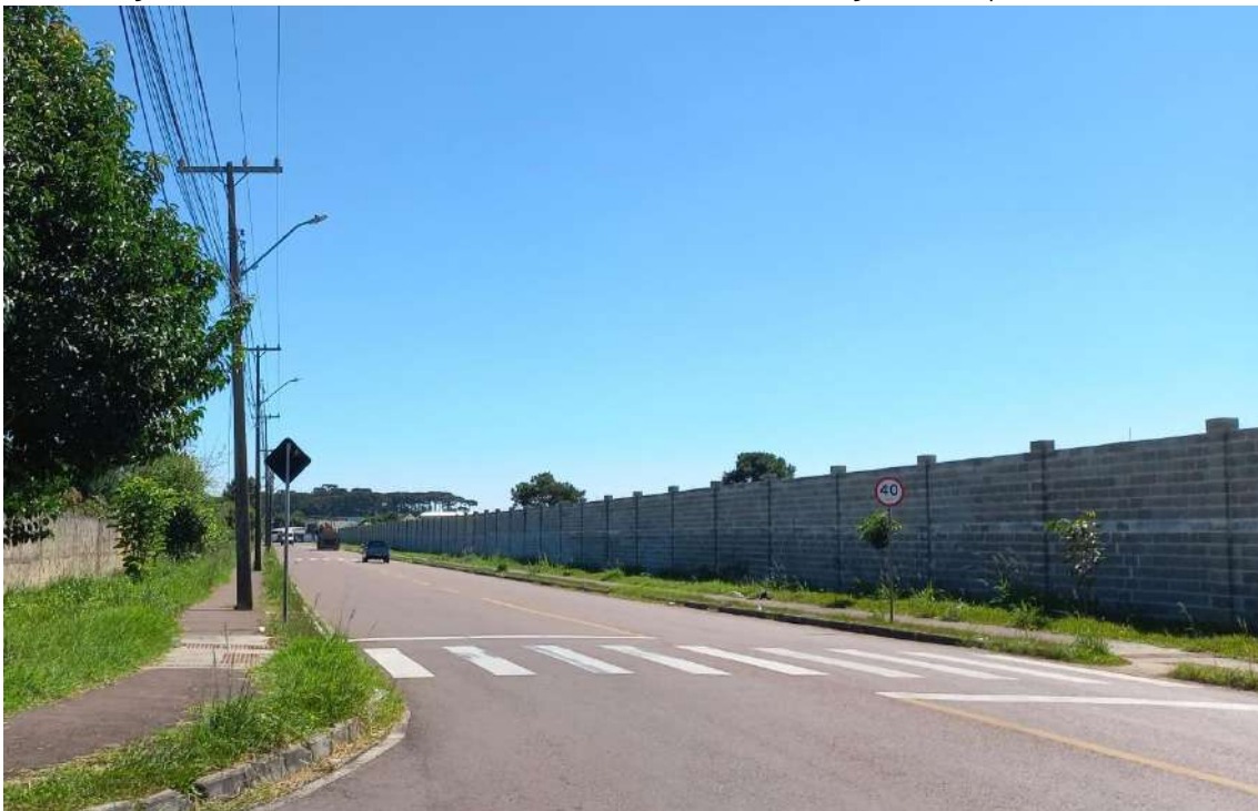
Figura 21. R. Florentino Suchla, em trecho defronte ao lote original do empreendimento
