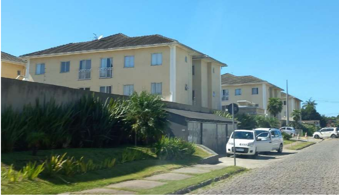
Figura 18. Condomínio residencial próximo ao empreendimento, na R. Nery Soares
