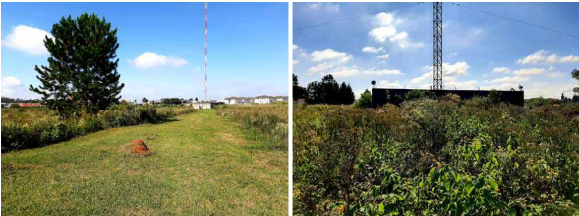
Ilustrações 09 e 10 – Características da torre de rádio com cerca de 60 metros que é sustentada por grandes cabos de aço.
