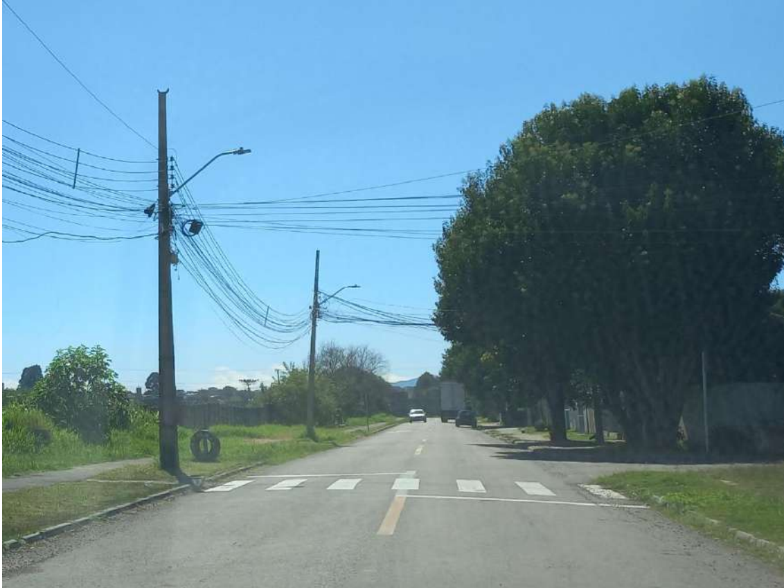
Figura 22. R. Nery Soares, em trecho defronte ao lote original do empreendimento
