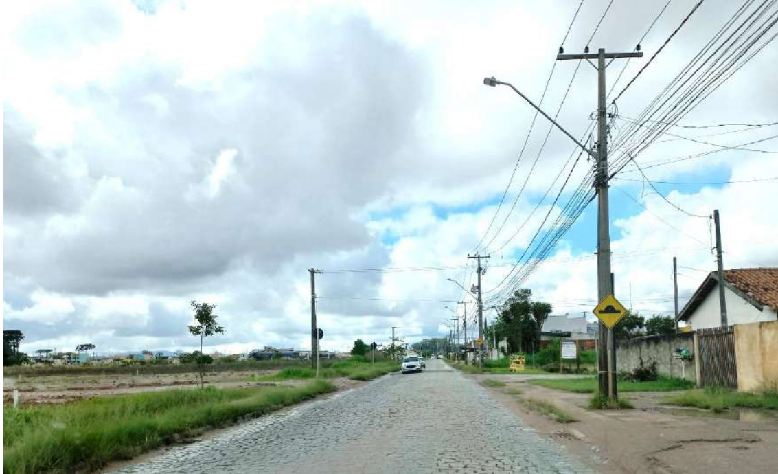
Figura 25. Rua Laerte Fenelon, via de acesso ao empreendimento
