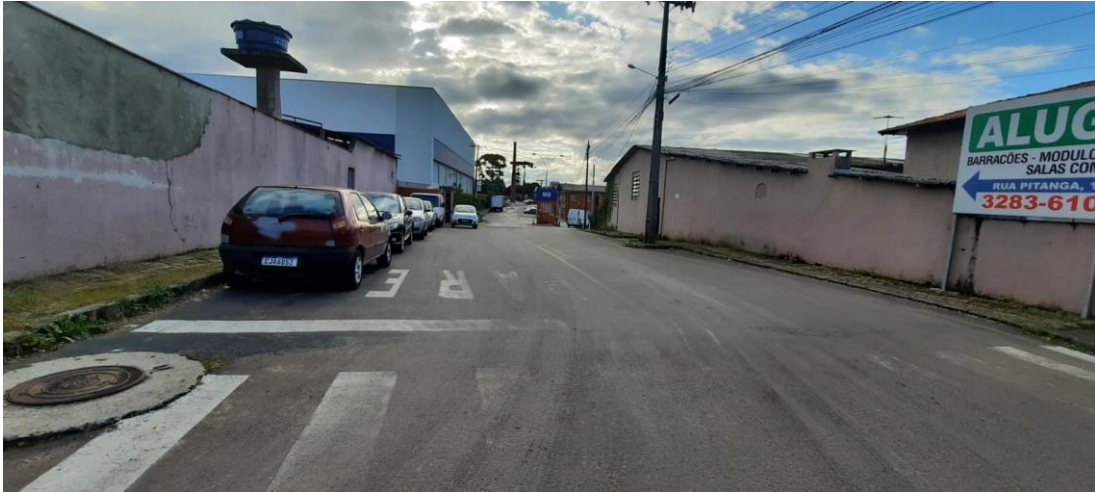
Foto 2 – via de acesso ao empreendimento.
