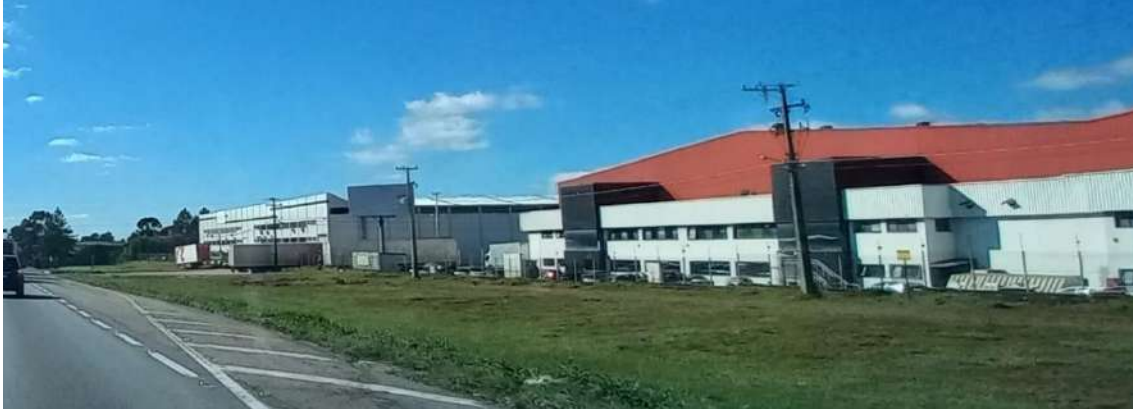
Figura 12. Atividade industrial e de prestação de serviço ao longo da Rodovia Federal BR-116
