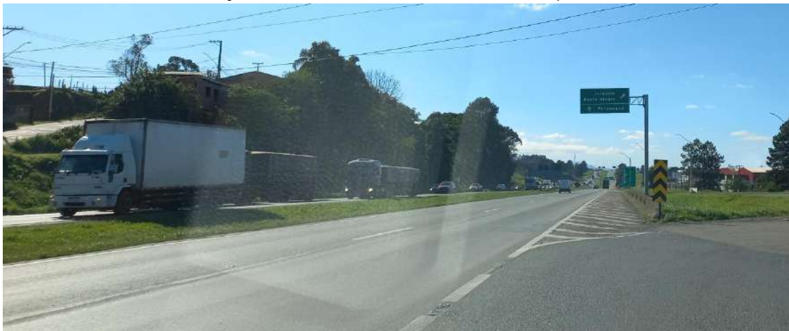
Figura 15. Rod. Federal BR-116, via de distribuição
