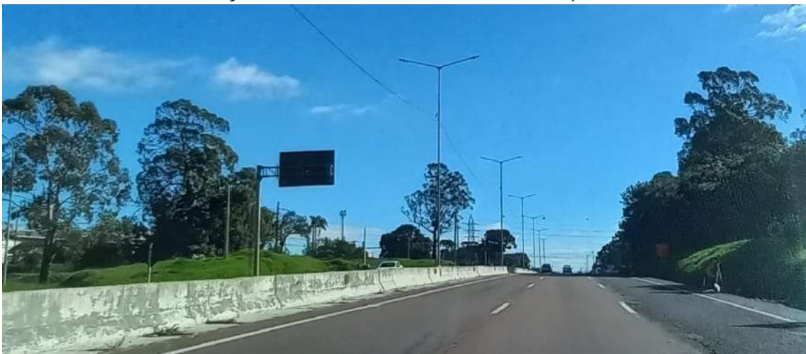
Figura 16. Rod. Federal BR-376, via de distribuição
