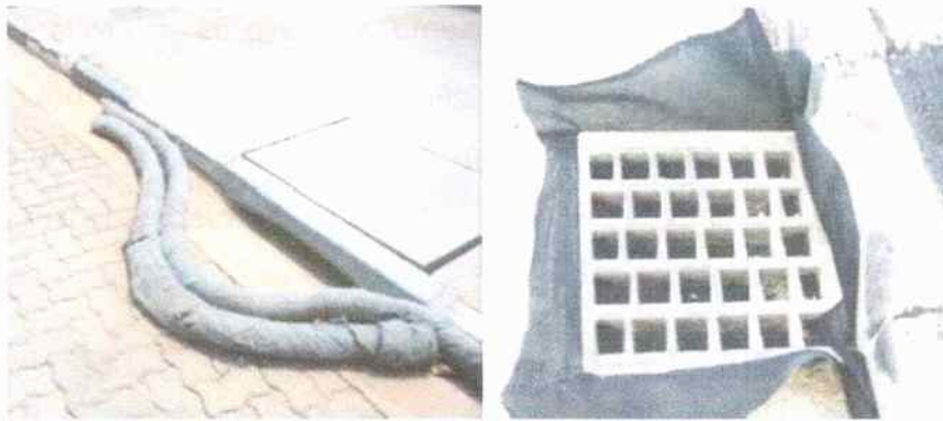
Figura 6 - Proteção de redes pluviais.
