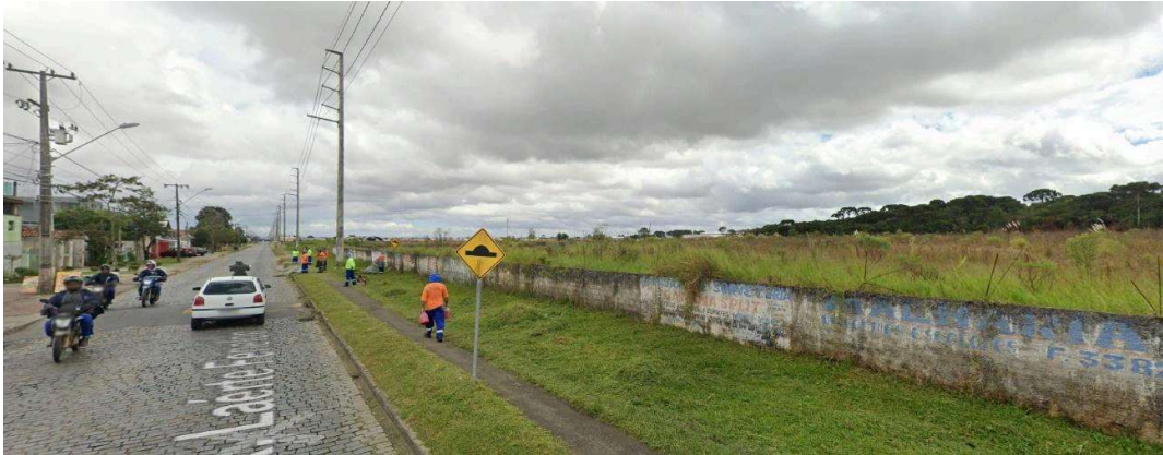
Figura 20 – Testada do imóvel Fonte: Google Maps (2022).
