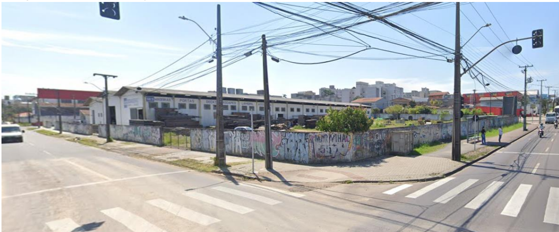
Figura 8. Testada do empreendimento, na esq. entre a Av. Rui Barbosa e a R. Maranhão, ano de 2023
