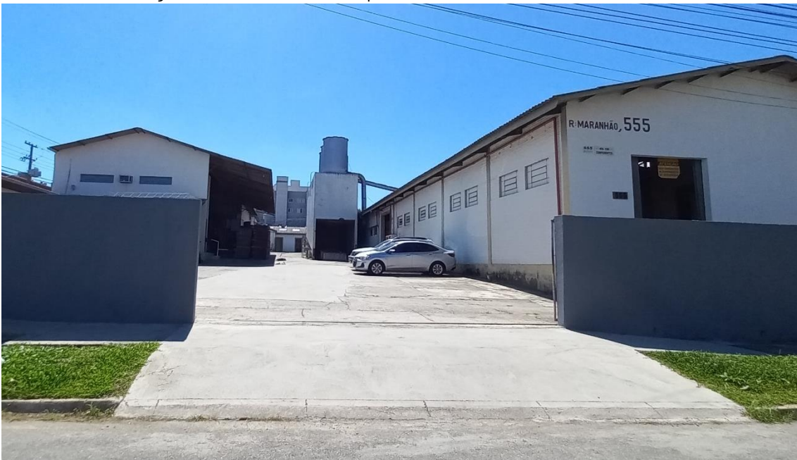
Figura 14. Acesso atual ao empreendimento, através da R. Maranhão
