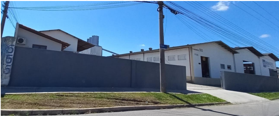
Figura 13. Construções existentes no terreno
