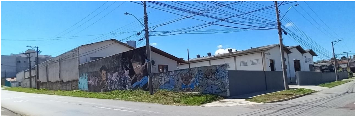
Figura 10. Testada do empreendimento, na esquina entre a R. Maranhão e a R. Frei Belino M. Treviso
