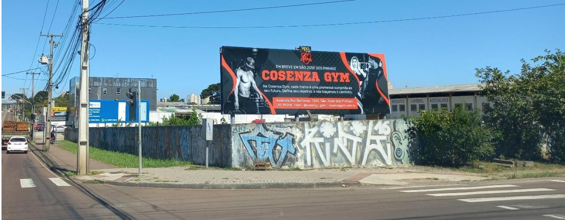
Figura 12. Testada do empreendimento, na esquina entre a Av. Rui Barbosa e a R. Francisco F. Machado
