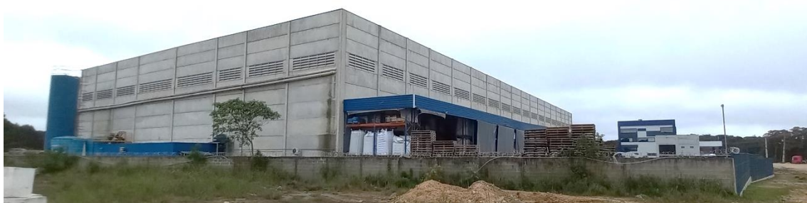
Figura 13. Vista do barracão existente na porção sul, observado da R. Padre Leopoldo Jarek
