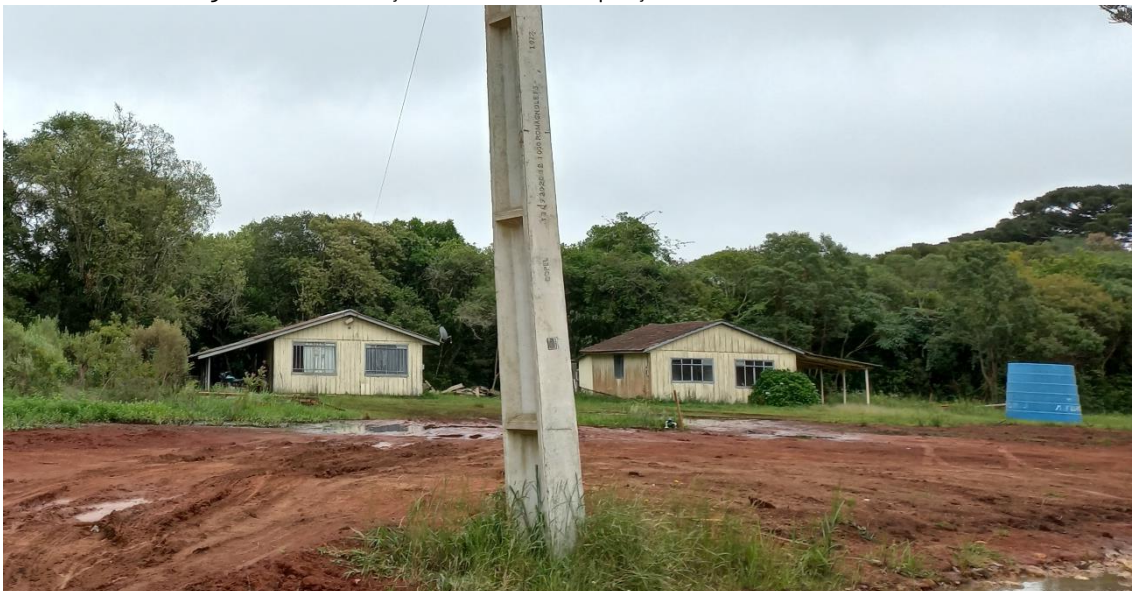
Figura 20. Construções existentes na porção norte, a serem demolidas
