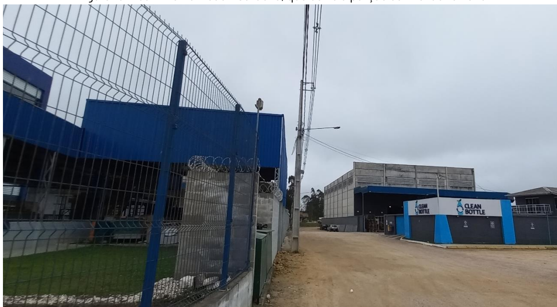
Figura 15. Rua Antônio Moacir Cardoso, que corta a porção central do terreno
