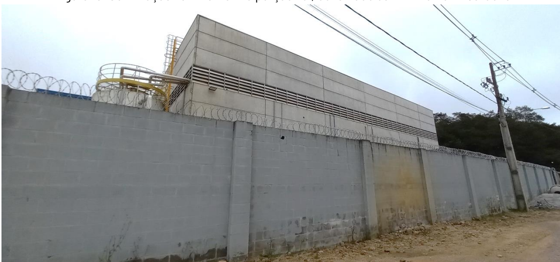
Figura 18. Construções existentes na porção sul, observado da R. Antônio M. Cardoso
