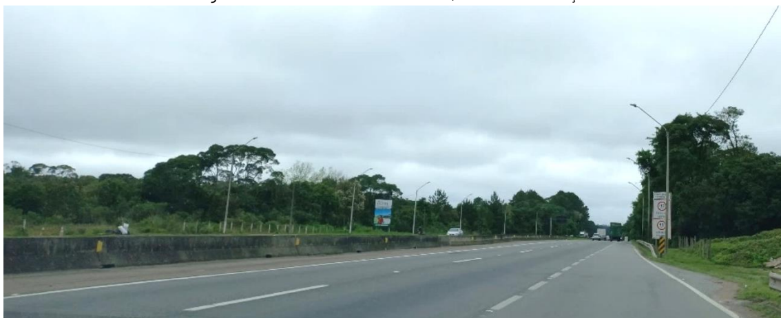
Figura 27. Rodovia Federal BR-376, via de distribuição
