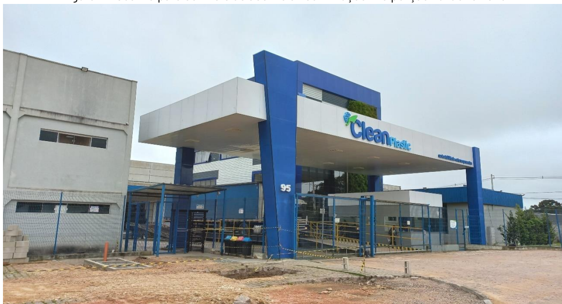
Figura 14. Guarita para controle de acesso às construções na porção sul do terreno
