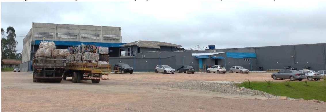
Figura 12. Construções existentes na porção central, com frente p/ a R. Padre Leopoldo Jarek
