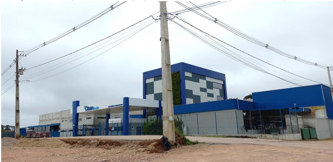
Figura 11. Construções existentes na porção sul do lote, com frente p/ a R. Padre Leopoldo Jarek
