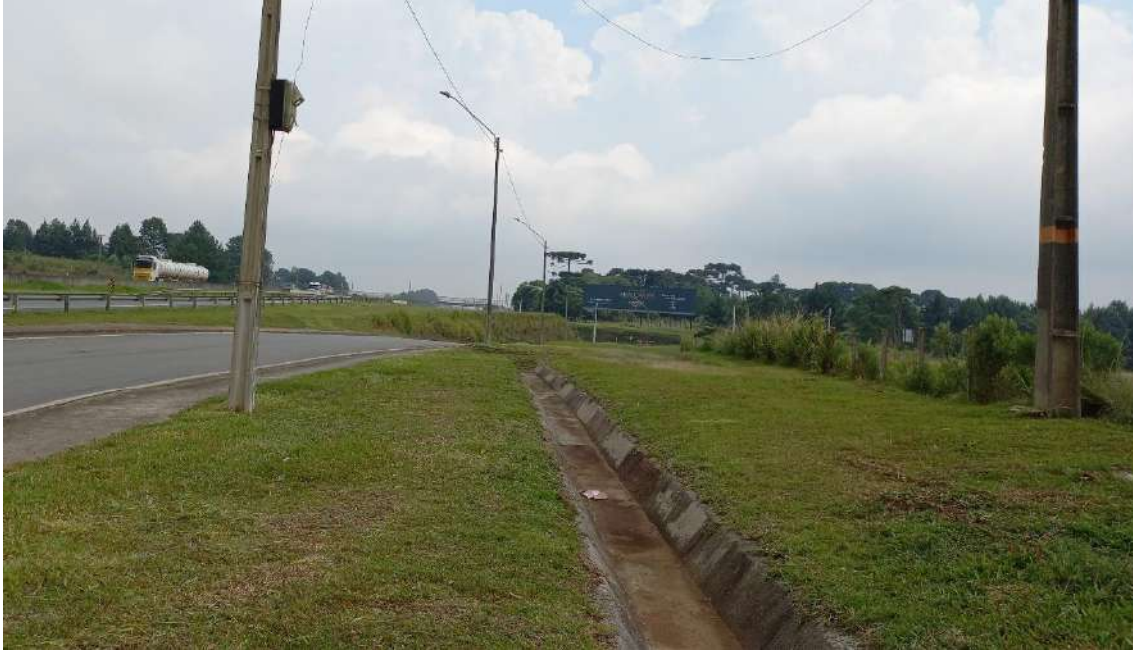
Figura 17. Vala de drenagem existente na via marginal da Rod. Federal BR-376, defronte à Área 02
