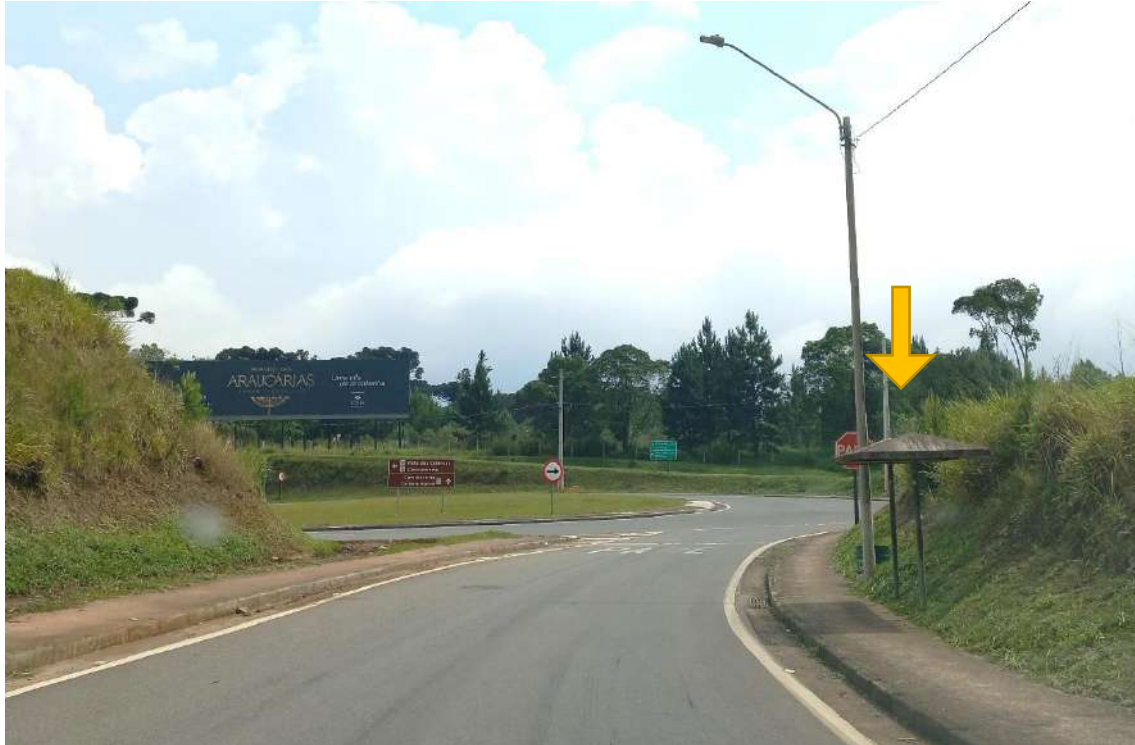
Figura 28. Abrigo de ônibus mais próximo, na Via Marginal da Rod. Federal BR-376
