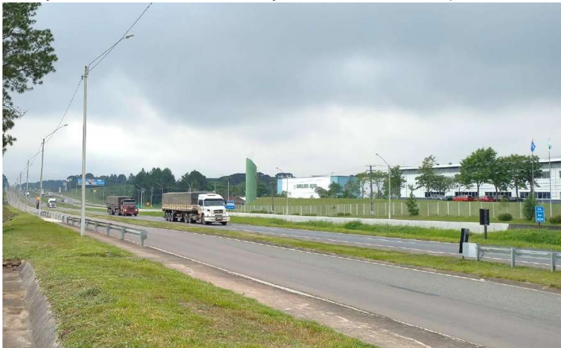
Figura 24. Rodovia Federal BR-376 e Via Marginal, em trecho defronte aos empreendimentos
