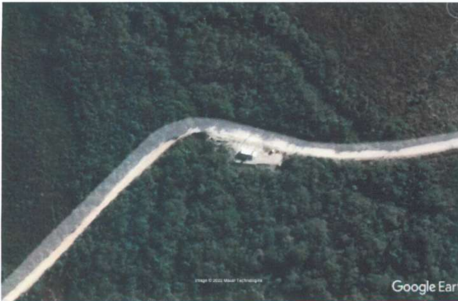
Registro do ponto de recalque.
