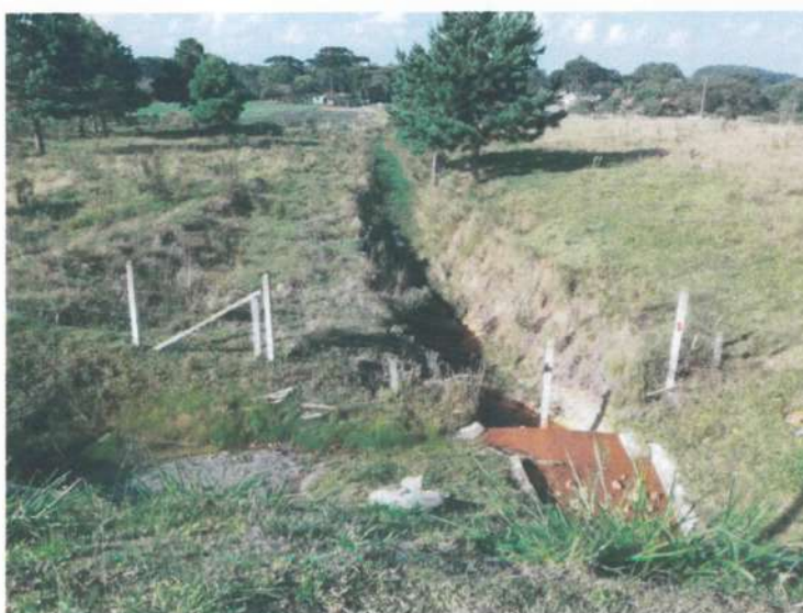
Nesta imagem houve saturação do sistema de montante onde foi necessário o aumento de vazão. (O bueiro antigo não estava vencendo).
