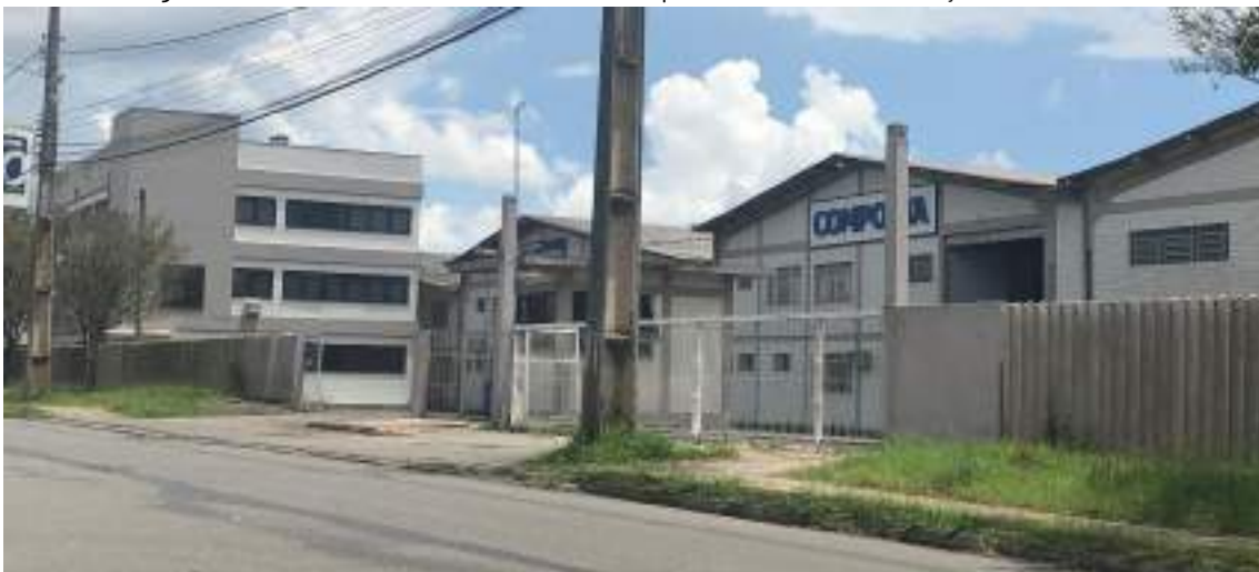
Figura 12. Parte frontal do futuro lote do empreendimento: construções existentes
