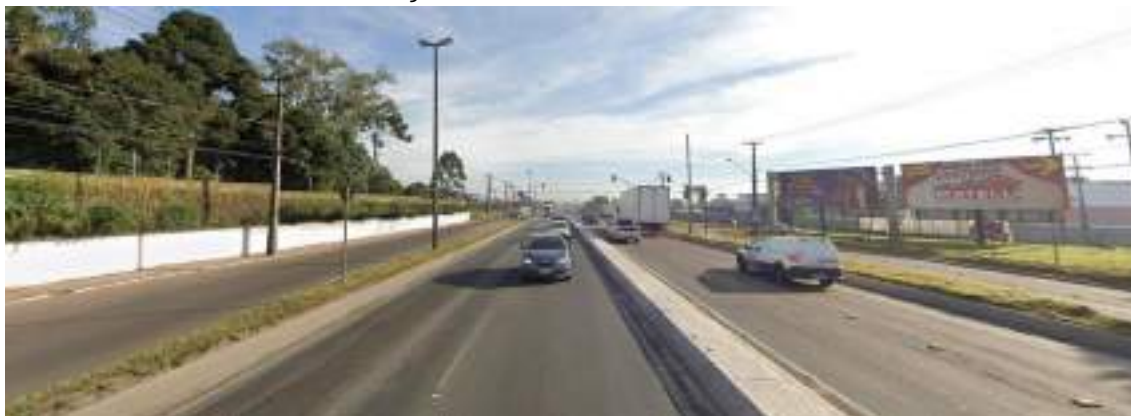
Figura 24. Rodovia Federal BR-376
