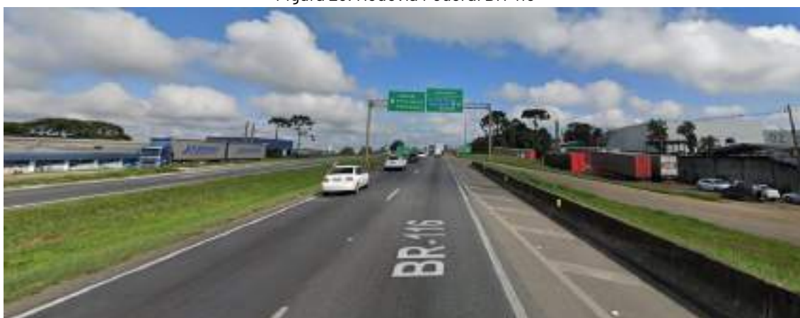
Figura 25. Rodovia Federal BR-116
