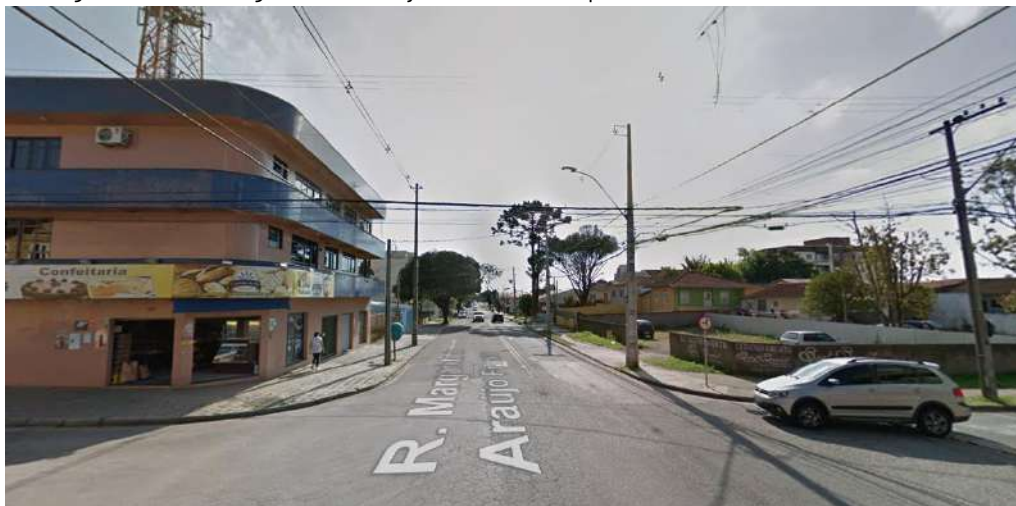
Figura 22. Rua Margarida de Araújo Franco, na esquina com a Rua Doutor Motta Junior
