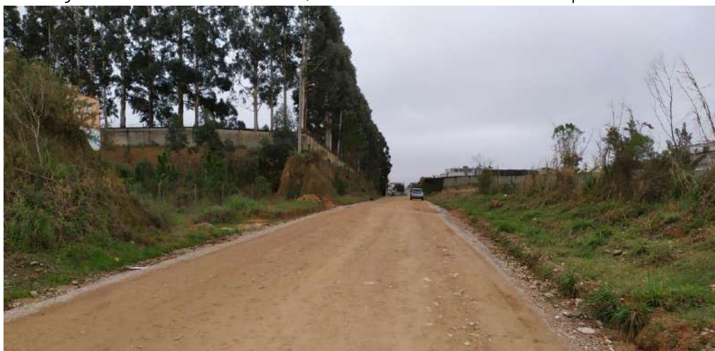
Figura 9. Rua Doutor Motta Junior, em trecho defronte ao lote do empreendimento
