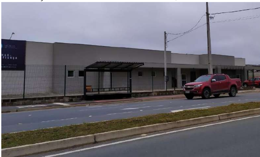
Figura 25. Ponto de ônibus na Avenida Rui Barbosa, sentido Área Rural
