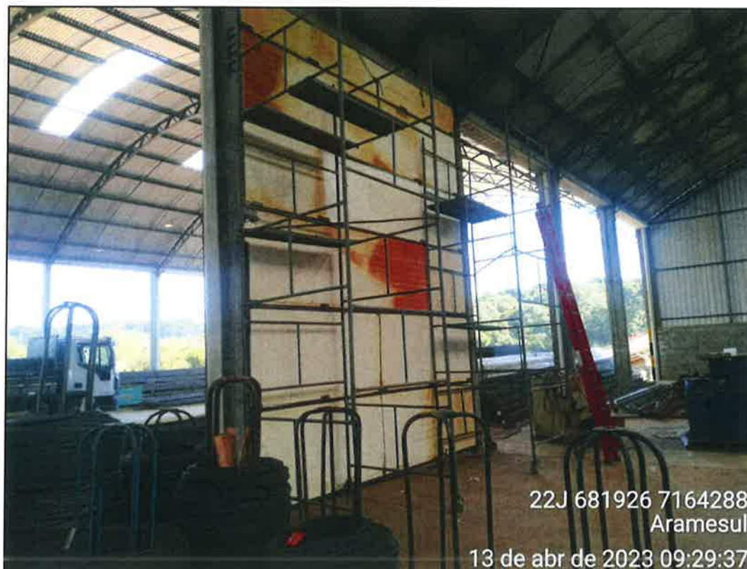
Figura 10: Placas de isolamentos acústico sendo instalados nos barracões.
