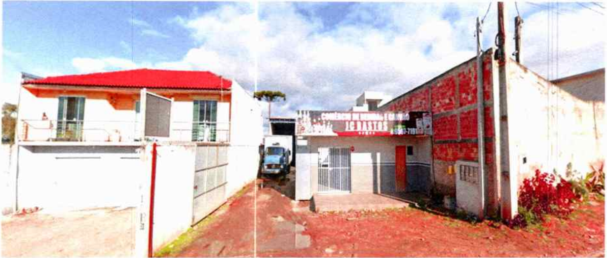
Figura 8: Vista de outras edificações comerciais existentes na Rua José Bajerski, bem próximo ao Lote 3A .
