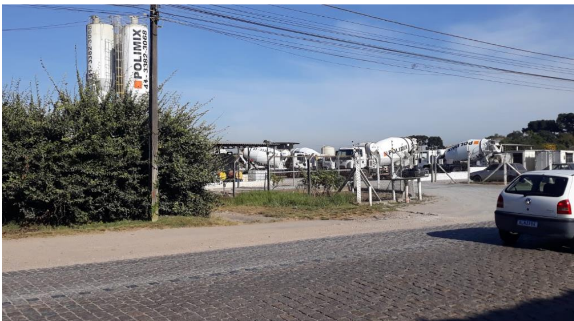
Figura 15 – Acesso ao Lote 551, pela Rua Dr, Murici
