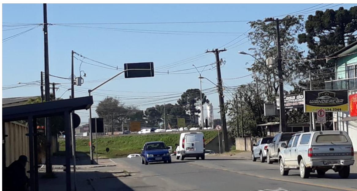
Figura 18 – Acesso da Rua Dr. Murici, antes do Contorno Leste de Curitiba
