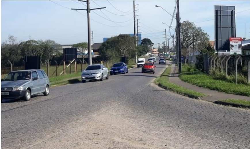
Figura 39 – Pavimento paralelepípedo, na frente do empreendimento
