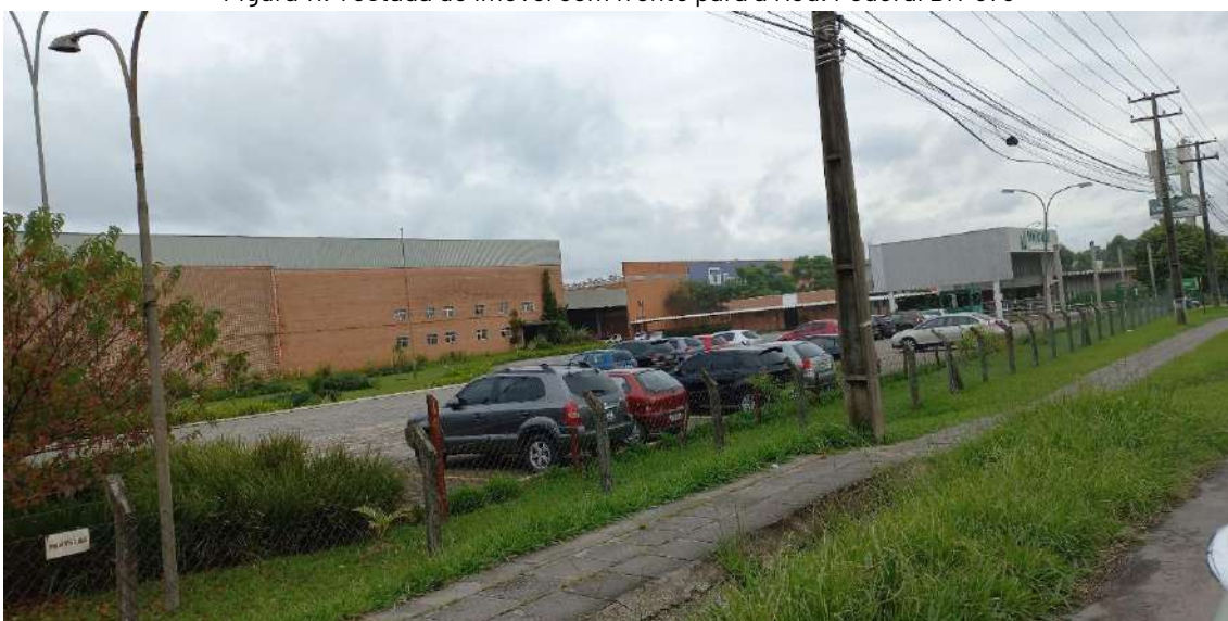
Figura 11. Testada do imóvel com frente para a Rod. Federal BR-376
