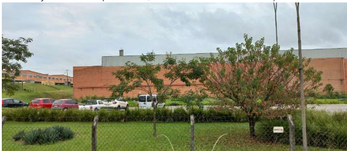
Figura 16. Lateral esquerda do lote, observado da Rod. BR-376 – construção existente
