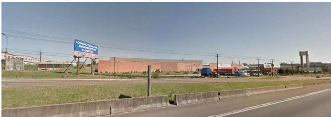
Figura 8. Testada do terreno para a Rod. Federal BR-376, ano de 2011
