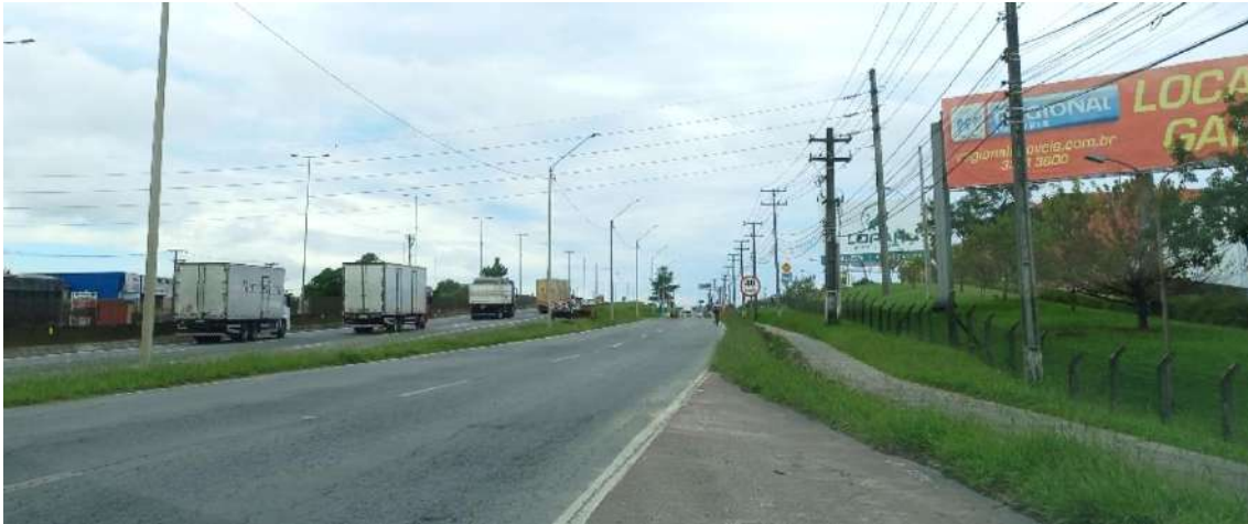
Figura 12. Via Marginal da Rod. Federal BR-376, em trecho defronte ao imóvel
