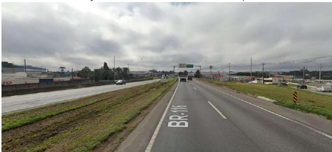
Figura 26. Rodovia Federal BR-116, via de distribuição
