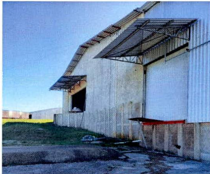
Foto 8: Fachada lateral do barracão 2/3/4.
