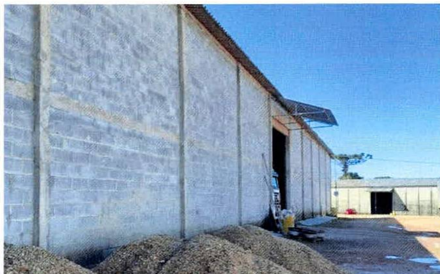
Foto 6: Elevação do Barracão 1 e aos fundos o Barracão 2/3/4 a regularizar para a Empresa Transportes Eronides.
