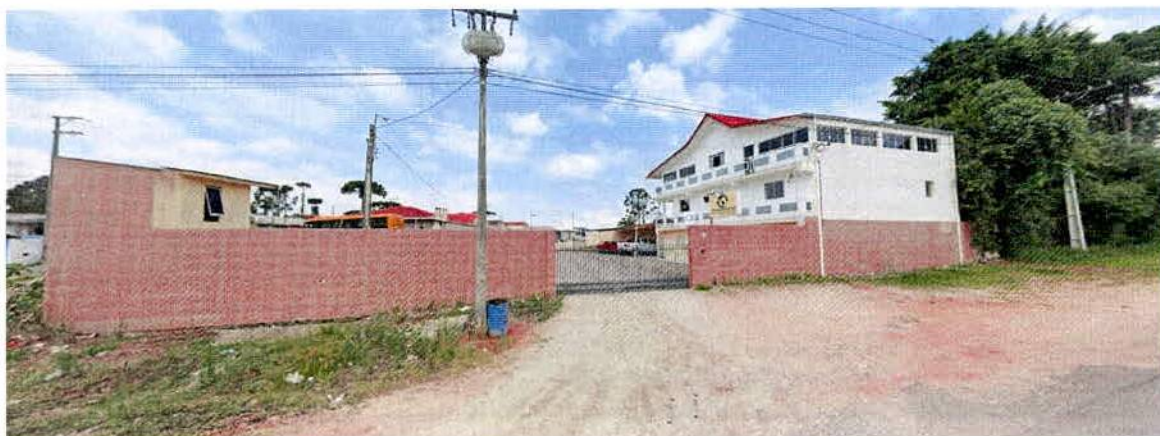
Foto 12: Imagem da Fachada frontal da Empresa Transportes Eronides a regularizar.
