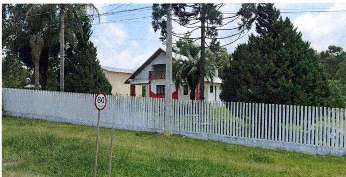
Foto 20: Fachada de outra Residência Unifamiliar situada no entorno da Empresa Transportes Eronides.
