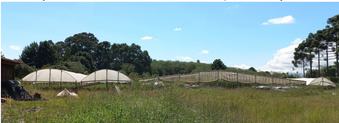
Figura 16. Vista do interior do terreno - estufas existentes para atividades agrícolas
