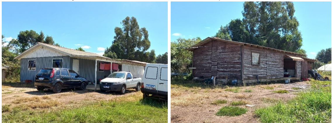
Figura 13. Vistas do interior do terreno - construções existentes
