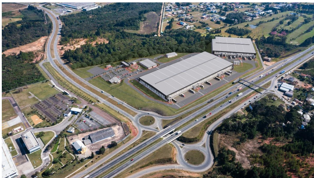
Figura 9: Vista Aérea do Empreendimento (Fonte: Elaborado por Arquik Arquitetura)
