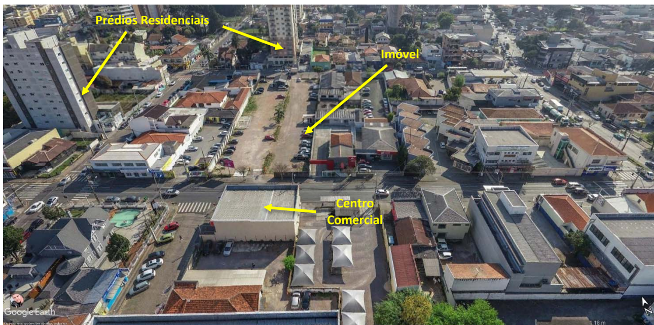
Imagem Google Earth de set/2021 – Demonstra a atual situação da região, com intenso uso comercial, e dois edifícios residenciais.
