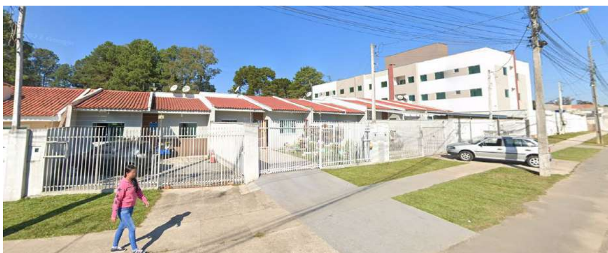
Figura 19: Fachada de outras Residências Unifamiliares situadas na Rua Constante Moro Sobrinho, no entorno do Lote F579.
