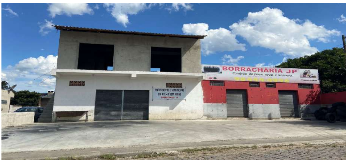
Figura 13: Vista da Borracharia JP e outra edificação comercial, situadas na Rua Constante Moro Sobrinho, em frente ao Lote F579.
