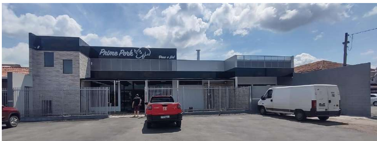
Figura 21. Testada, construção existente, estacionamento de clientes e acessos 4 e 5 pela Rua Alfredo Pinto : de pedestres (funcionários + público ao açougue) e veículos carga e descarga do açougue (à direita) (Fonte: Juliano Weronka Arquitetura Ltda, 2022)
