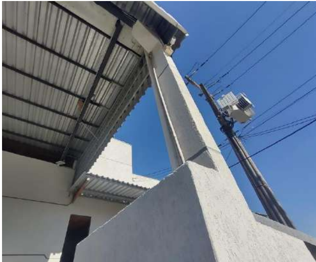
Figuras 58 e 59. Relógio padrão e alimentação da rede de energia elétrica (Fonte: Juliano Weronka Arquitetura Ltda, 2022)
