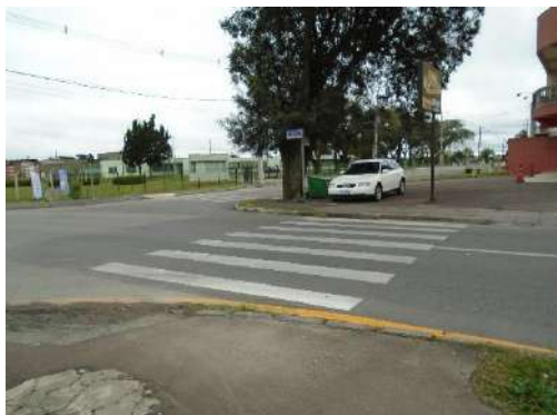
Foto 12 – Sinalização de travessia de pedestres na Rua Anneliese Gellert Krigsner.
