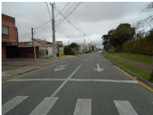
Foto 9 – Rua Anneliese Gellert Krigsner é asfaltada, pista dupla com um sentido, sem área de estacionamento. É via de acesso ao empreendimento.
