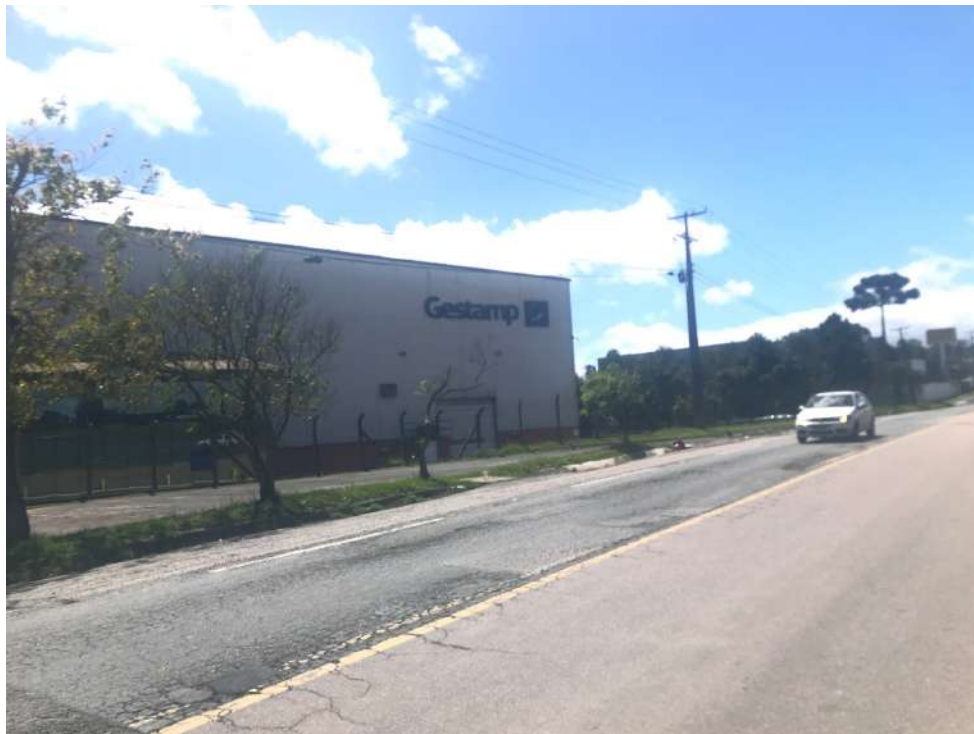
Figura 5 - Rua José Semes, visto da rua o lote do Empreendimento
