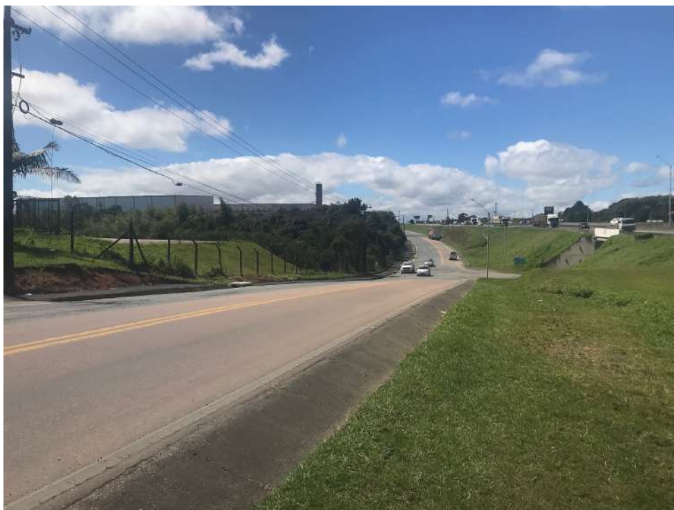
Figura 7 - Rua José Semes, vista do lado esquerdo do lote do empreendimento.
