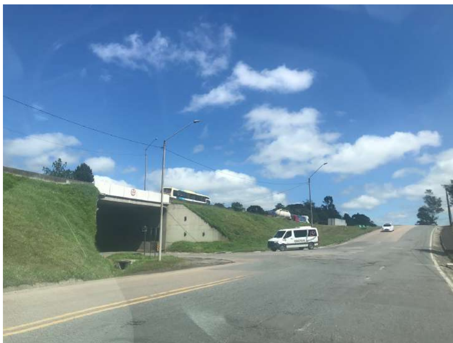
Figura 19 - Rua José Semes (trincheira que dá acesso ao outro lado da pista sentido BR 376/BR 277)
