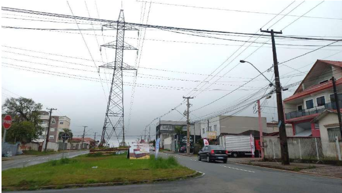
Figura 34. Avenida das Torres, via de distribuição
