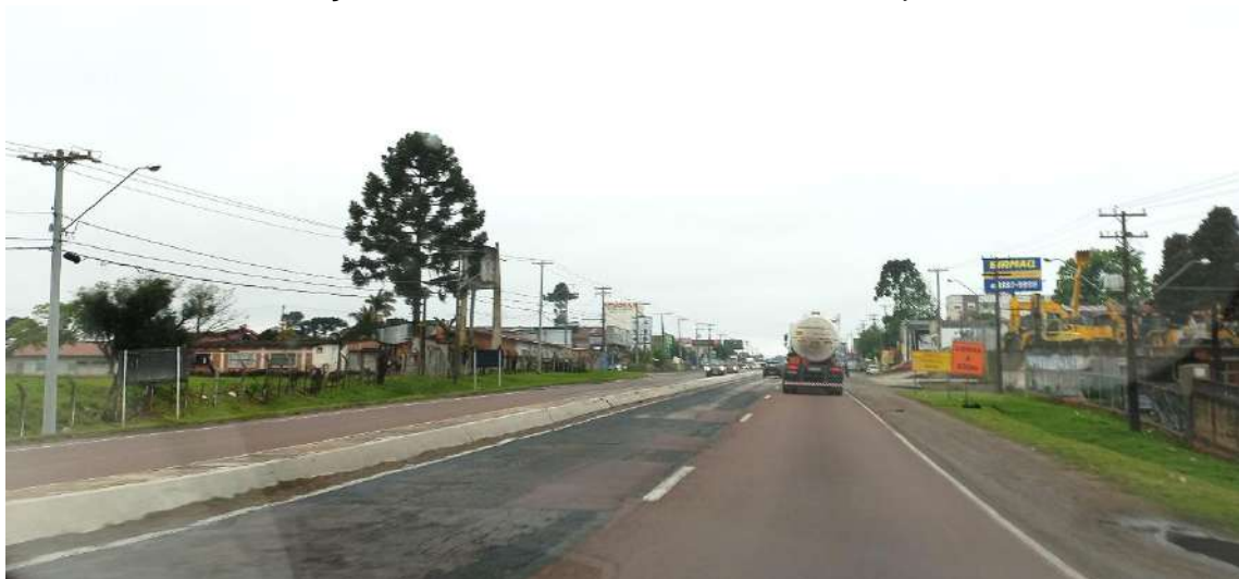
Figura 35. Rodovia Federal BR-376, via de distribuição
