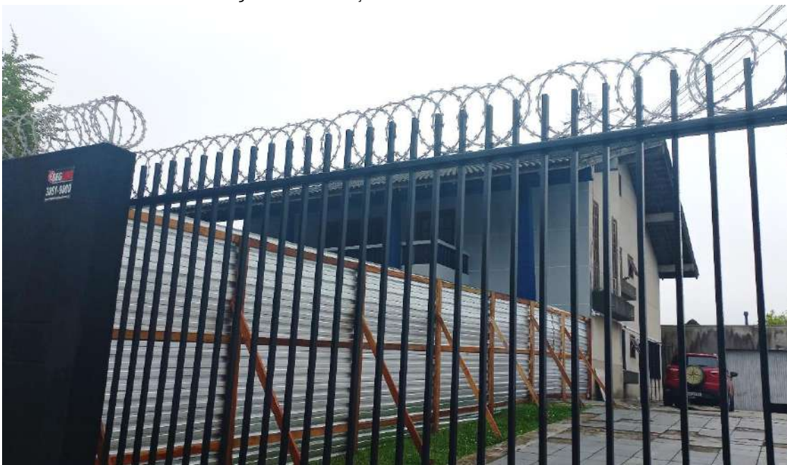
Figura 11. Construção existente a ser demolida
