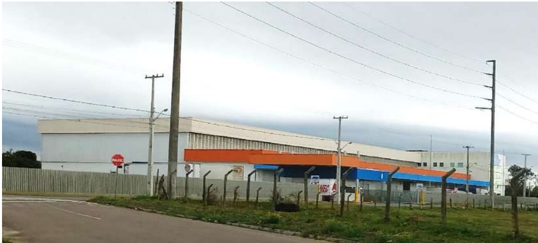
Figura 10. Testada do imóvel com frente para a Alameda Bom Pastor
