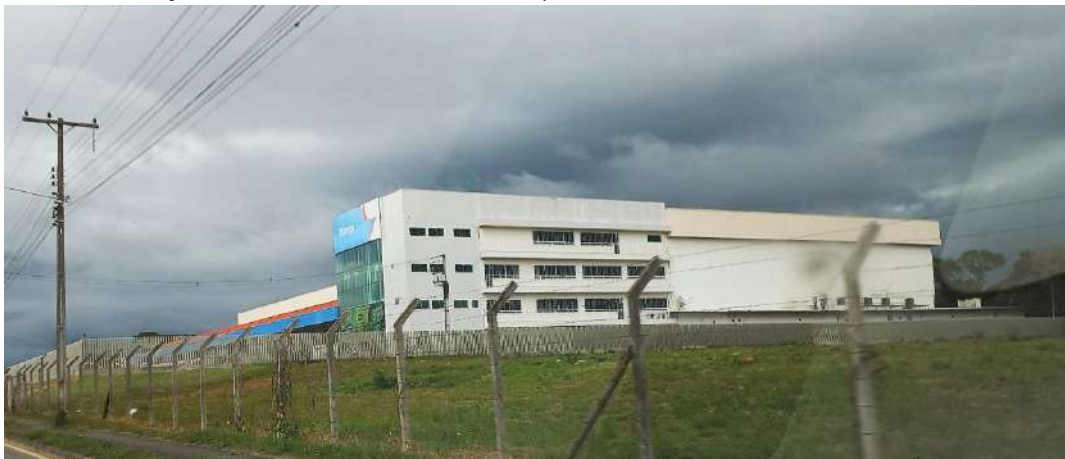
Figura 11. Lateral direita do imóvel, de quem observa da Alameda Bom Pastor
