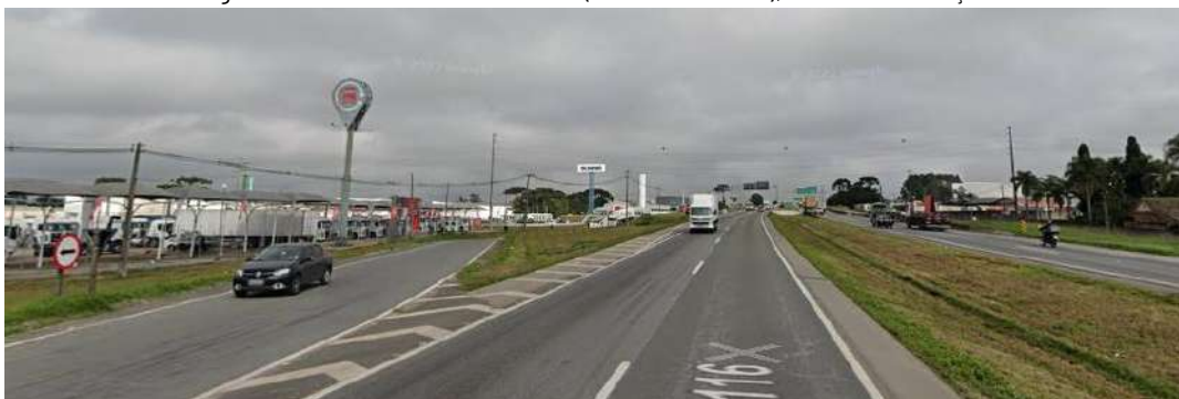
Figura 24. Rodovia Federal BR-116 (Contorno Leste), via de distribuição
