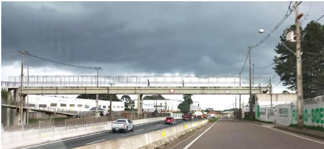
Figura 23. Rodovia Federal BR-376, via de distribuição
