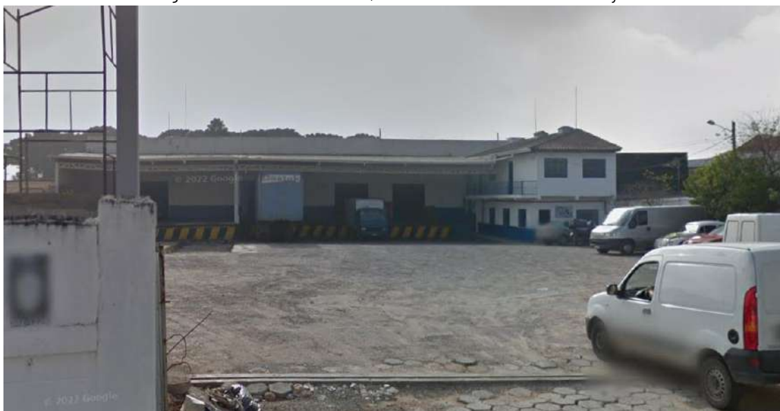
Figura 14. Interior do terreno, observado da Rua Tavares de Lyra
