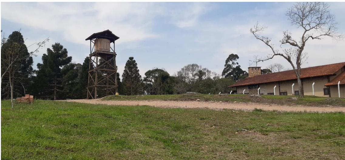
Figura 10: Reservatório 1. Fonte: acervo do autor
