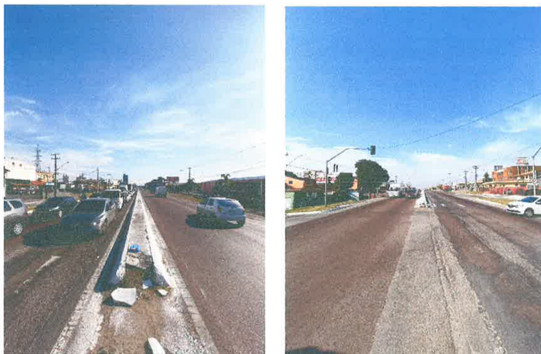
Figura 28 – Rodovia BR-376 com destaque para o revestimento e as faixas de rodagem
