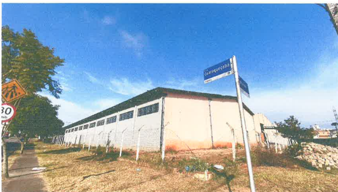
Figura 14 – Fundos do empreendimento
