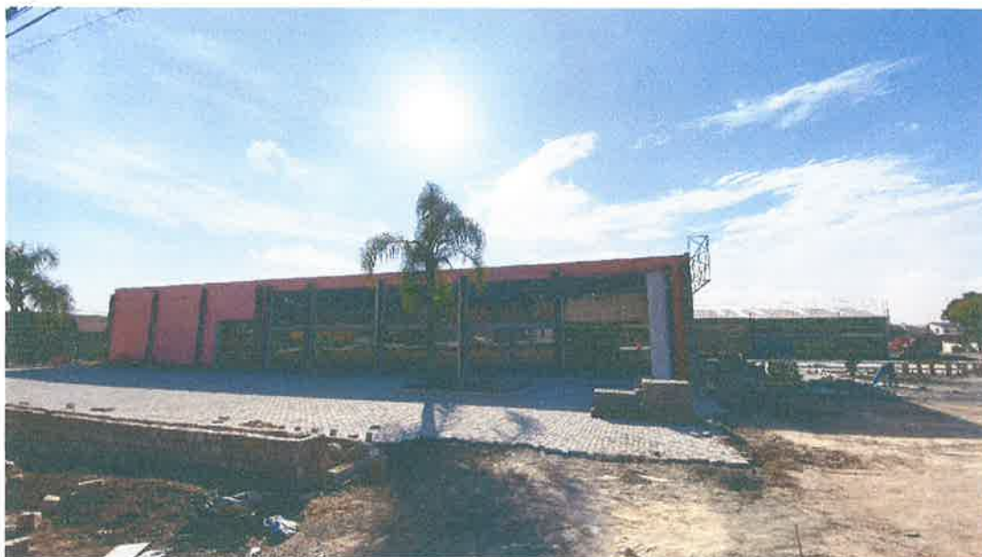
Figura 13 – Fachada em construção
