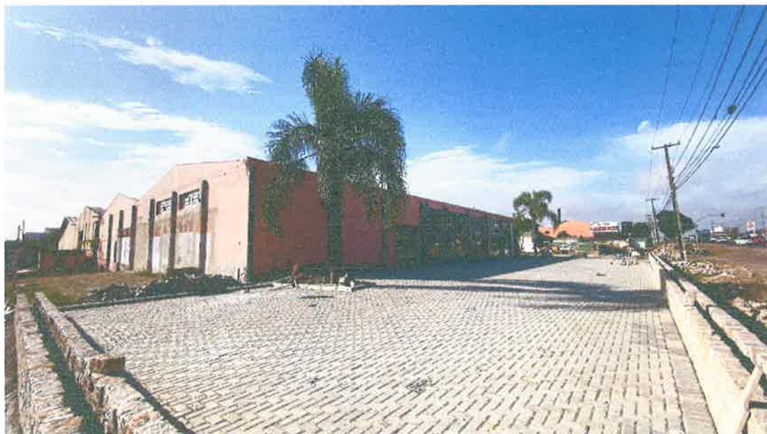
Figura 12 – Vista lateral do estacionamento e fachada
