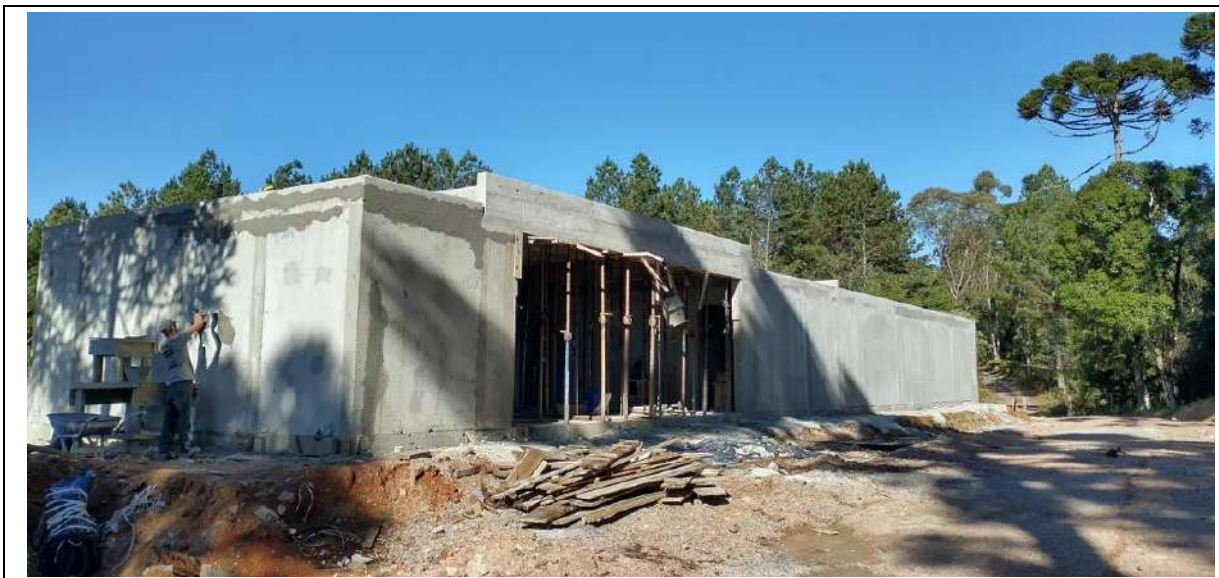
Figura 22 – Vista da recepção em construção
