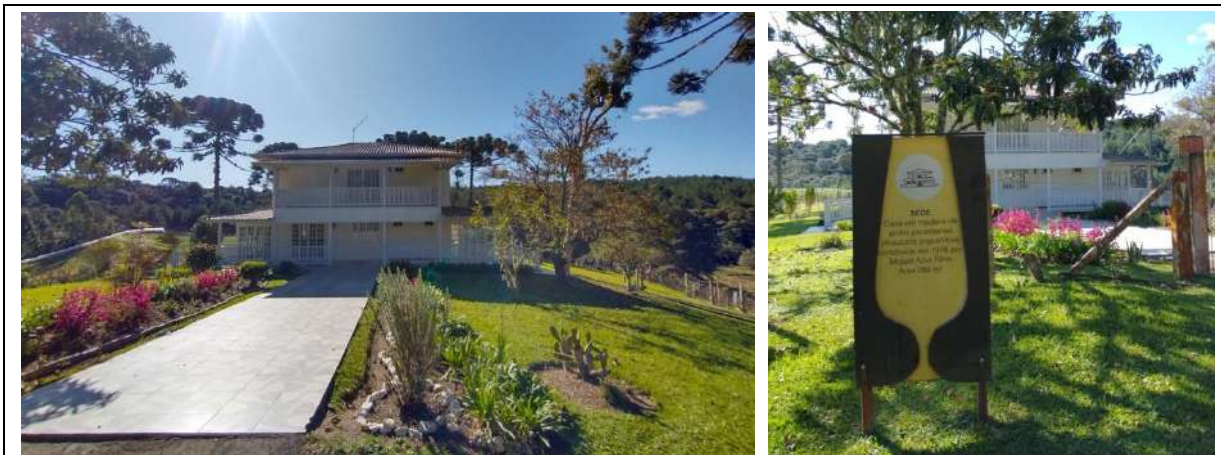
Figura 12 - Vista externa da Casa Sede
