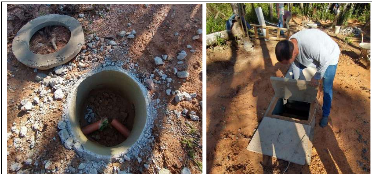
Figura 9 – Sistema individual de tratamento para a futura pousada
