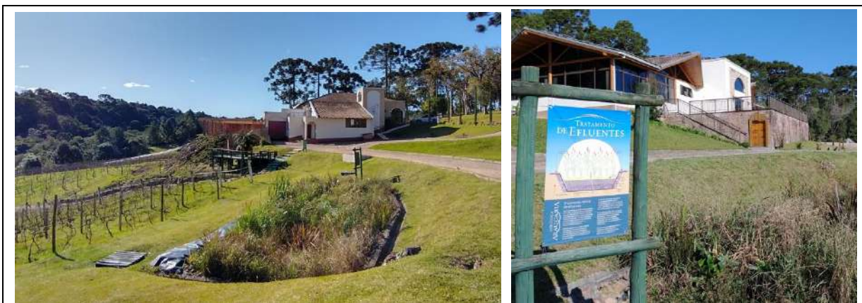
Figura 8 – Estação de Tratamento de Efluentes (ETE)
