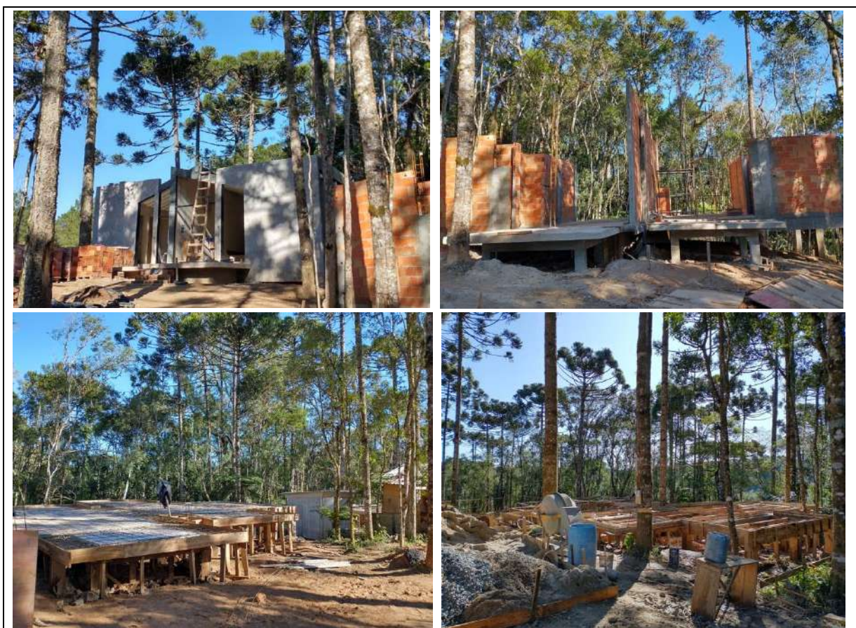
Figura 23 – Vista dos chalés em diferentes etapas de construção
