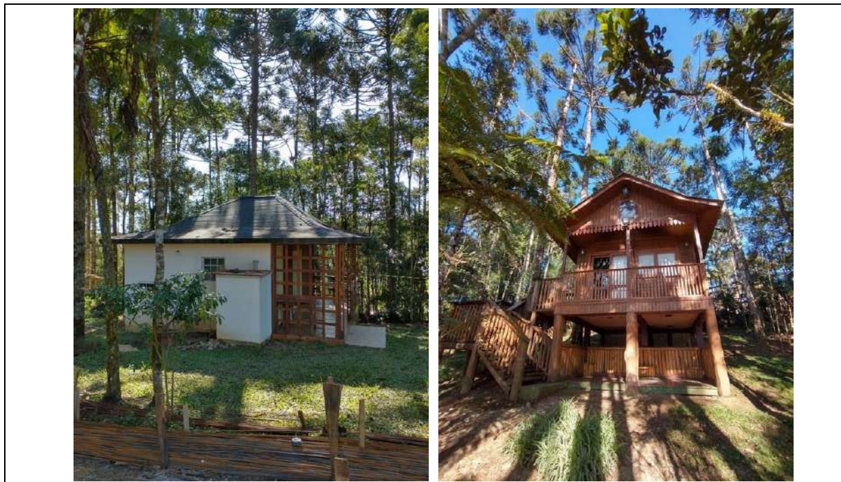
Figura 24 – Vista dos chalés existentes
