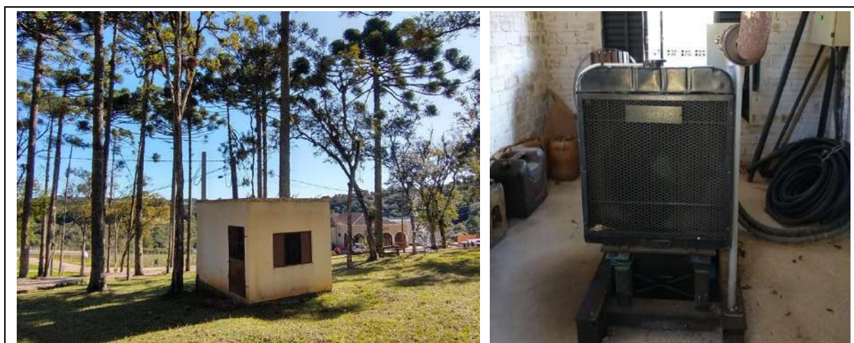
Figura 7 – Gerador e placas fotovoltaicas
