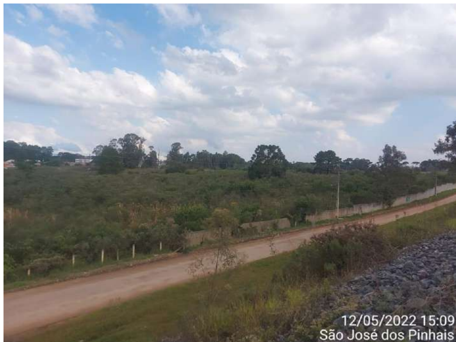
Fotografia 5 - Vista geral do imóvel.
