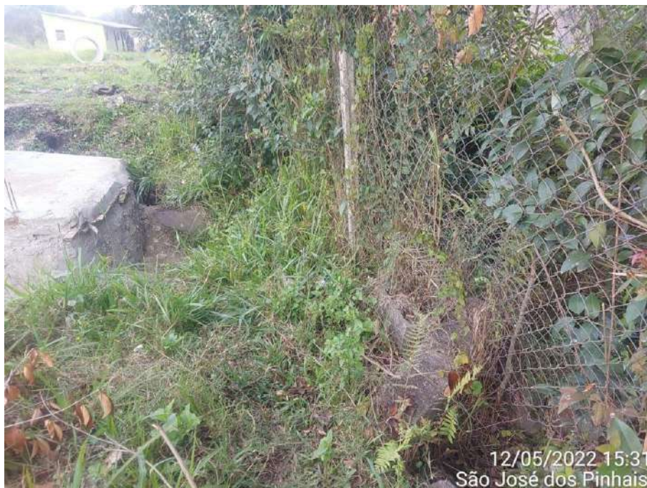
Fotografia 3 - Tubulação instalada em imóvel vizinho para escoamento da água.
