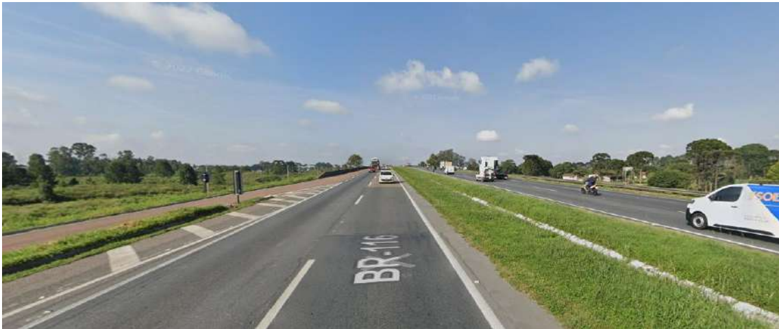
Figura 21. Rodovia Federal BR-116 (Contorno Leste), via de distribuição
